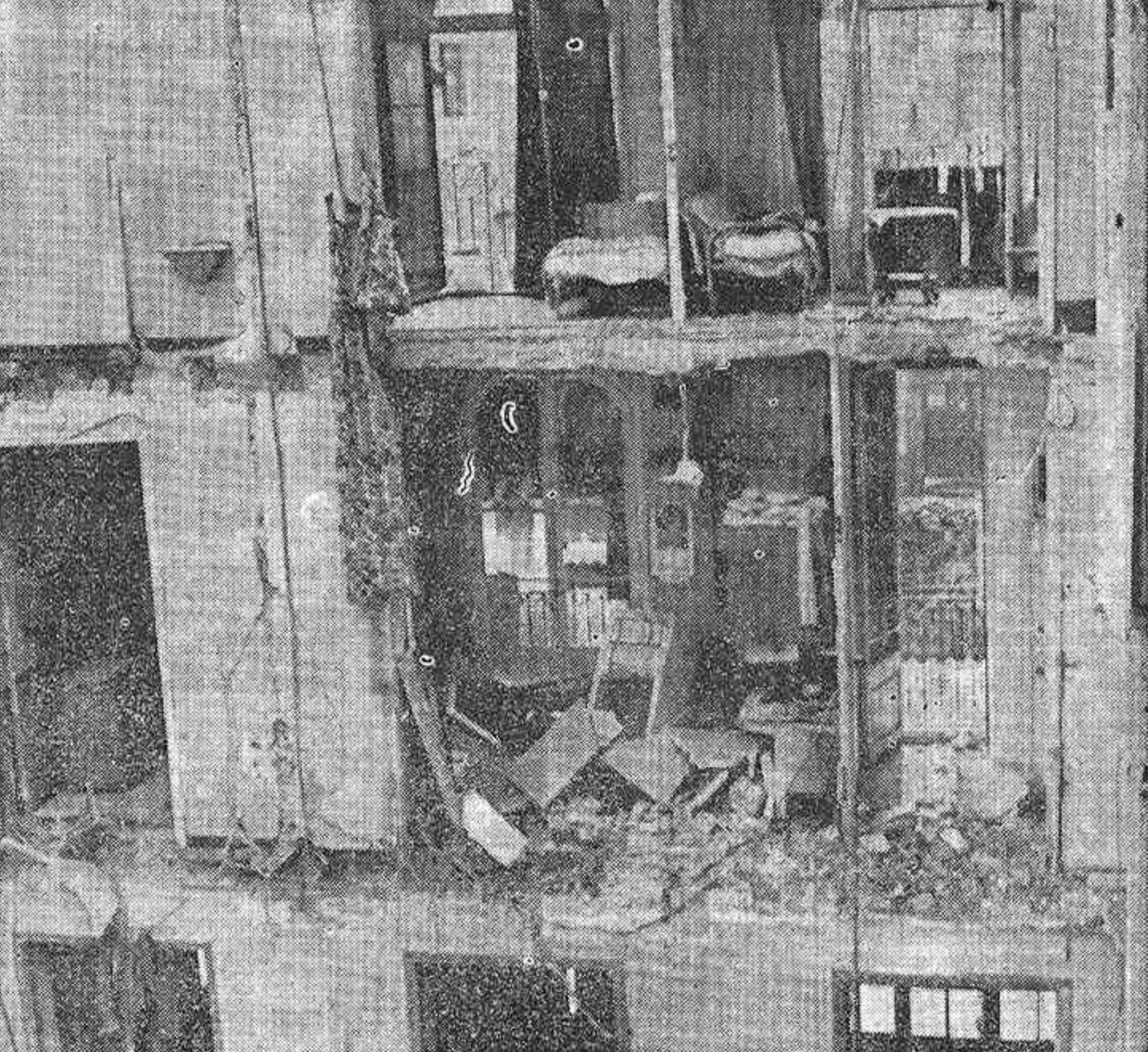
BARCELONA, 3. (Cifra). — Un muerto y cinco heridos, algunos de ellos muy graves, han sido retirados ya entre los escombros de la casa de la calle de la Unión, 1, que se ha hundido esta mañana a consecuencia de unas obras que se realizaban en los bajos para construir un aparcamiento de coches. El muerto, que no ha podido ser identificado, por carecer de documentación, se cree que es uno de los obreros que trabajaban en las mencionadas obras.
