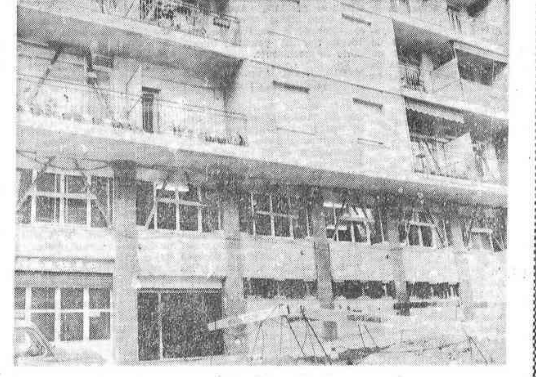
BARCELONA. — Aspecto exterior del edificio de la Rambla Volard-Guarnado, amenazado de derribamiento y que tuvo que ser apuntalado, al parecer afectado por las obras de construcción del "Metro". — (Círa Gráfica)
