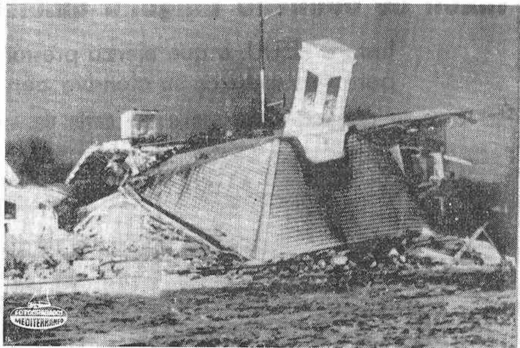
SHAKER HEIGHTS (Ohio). — Una violenta explosión de origen indeterminado hasta ahora, lo prácticamente el edificio municipal de esta localidad. Unas 14 personas resultaron heridas. Después de la explosión sólo quedaron en pie dos paredes y el tejado aparecía sobre el suelo. Dicho edificio servía como jefatura de policía, tribunal y prisión. — (Telefoto UPI-CIFRA)
