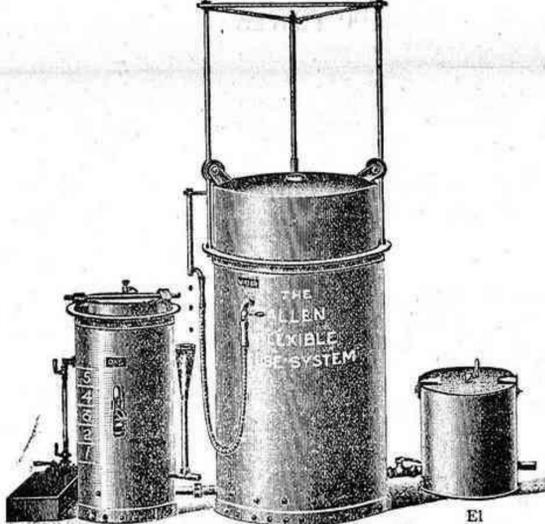
Receptáculos de sobras. El engendrador de gas. El tenedor de gas. El purificador. Receptáculos de "carbido"
