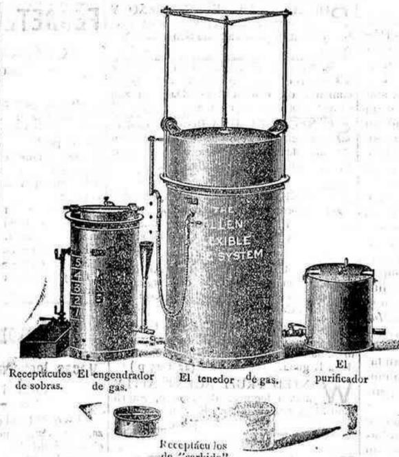
EN el presente grabado el tenedor de gas está representado en su condición baja al lugar donde el agua se derrama del Tubo flexible en el embudo que comunica con el compartimiento que contiene el "Carbido" con el gas.
