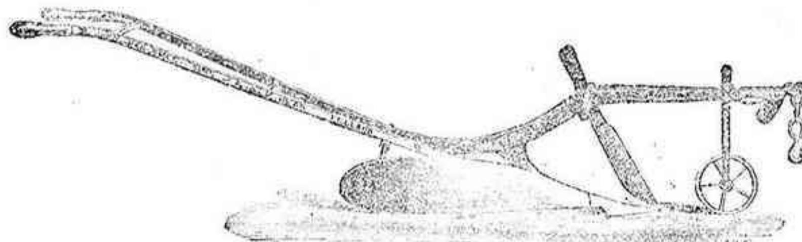
Estos arados combinan todas las ventajas de los mejores arados ingleses. Son muy fuertes en todas sus partes; el timón, el armazón y la manecilla del lado de la tierra son de hierro forjado en una sola pieza, dándoles de este modo gran resistencia y evitando el empleo de tornillos. La veta-terra es de acero y la reja de hierro fundido o de hierro forjado acerado, según se prefiera. Las rejas para el arado N.S.W.O. están marcadas R.H.A., y las para los arados N.S.W. 1, 2 y 3, R.N.F.
