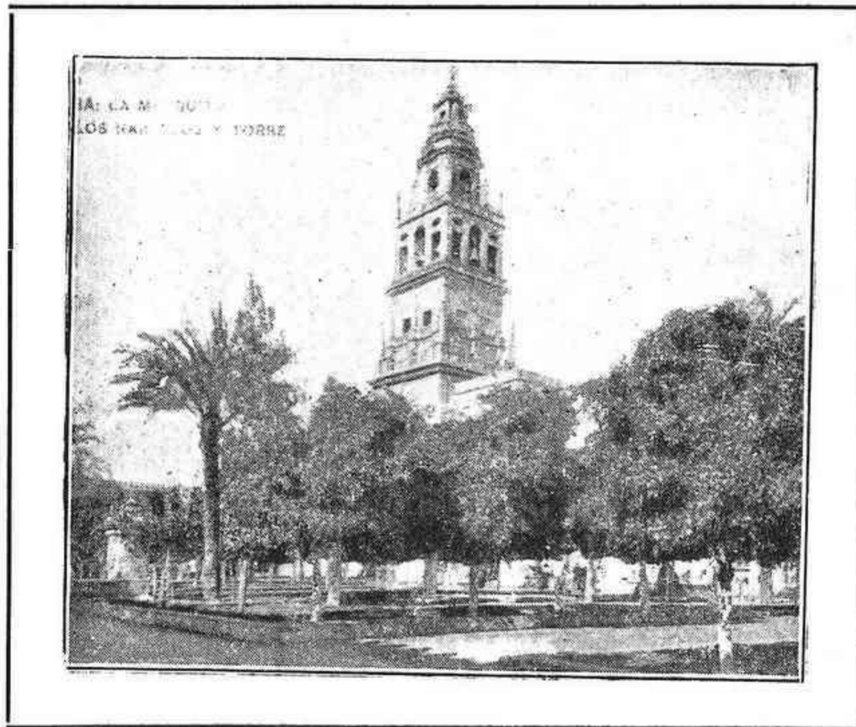
CÓRDOBA: — PATIO DE LOS NARANJOS
