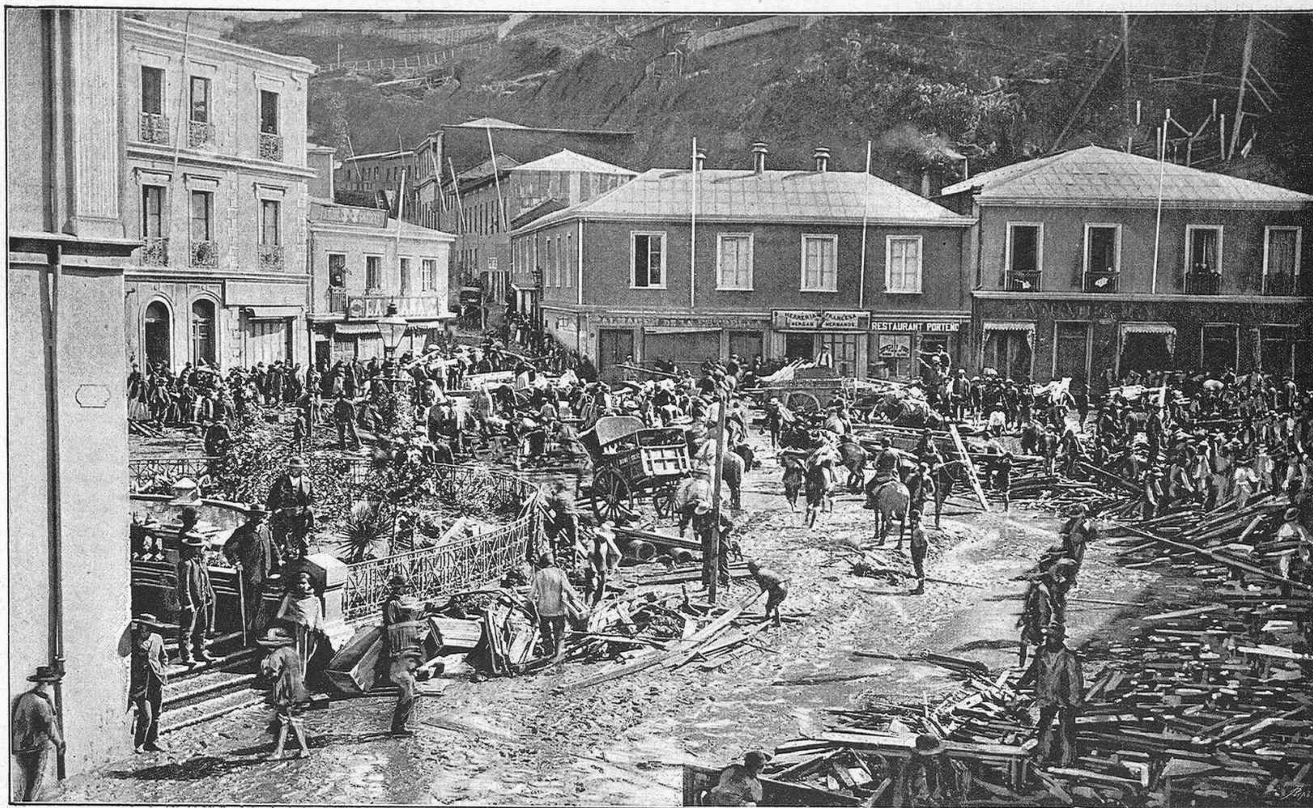
Valparaíso. — ESTADO DE LA PLAZA DE ANIBAL PINTO, DESPUÉS DE LA INUNDACIÓN.
