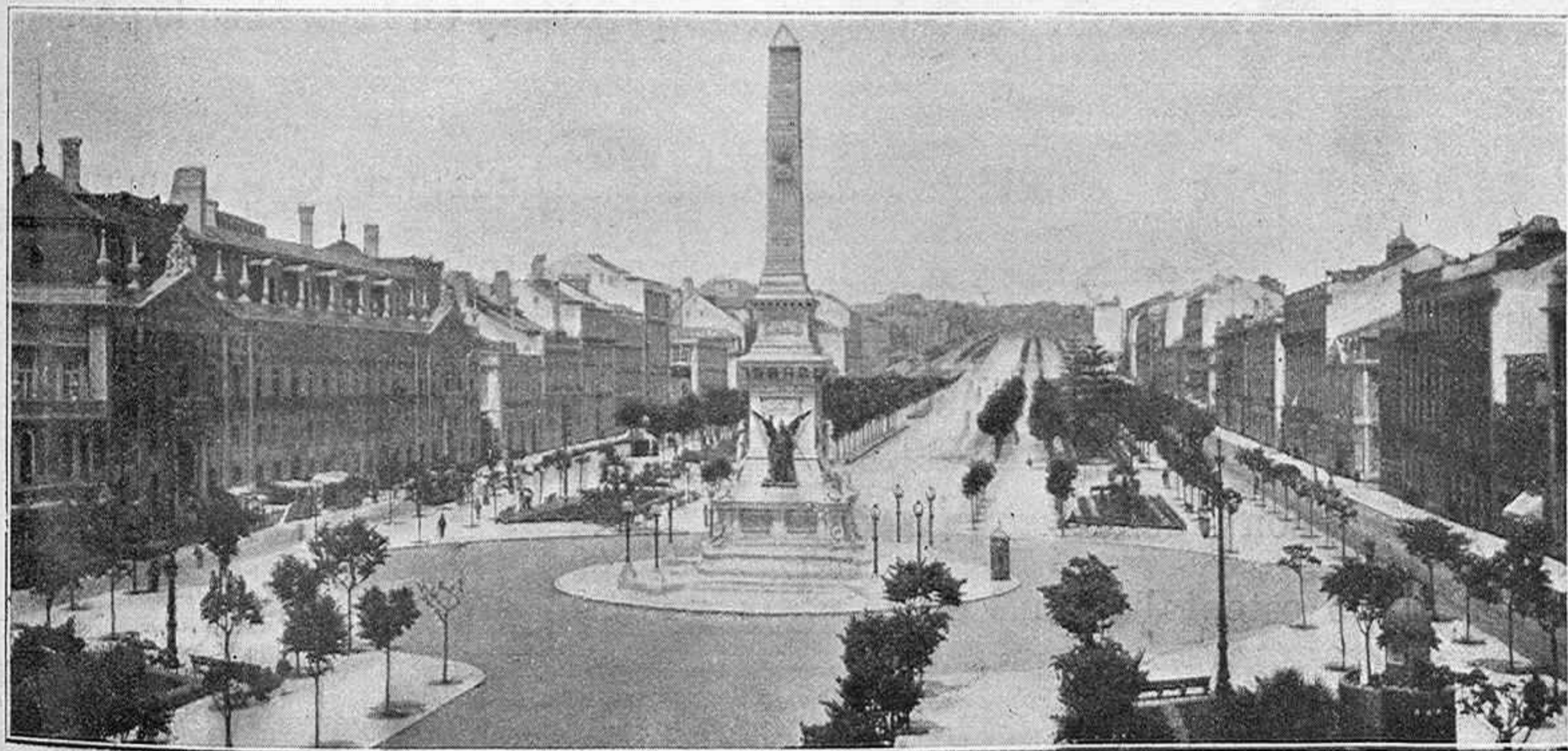
AVENIDA DE LA LIBERTAD.
