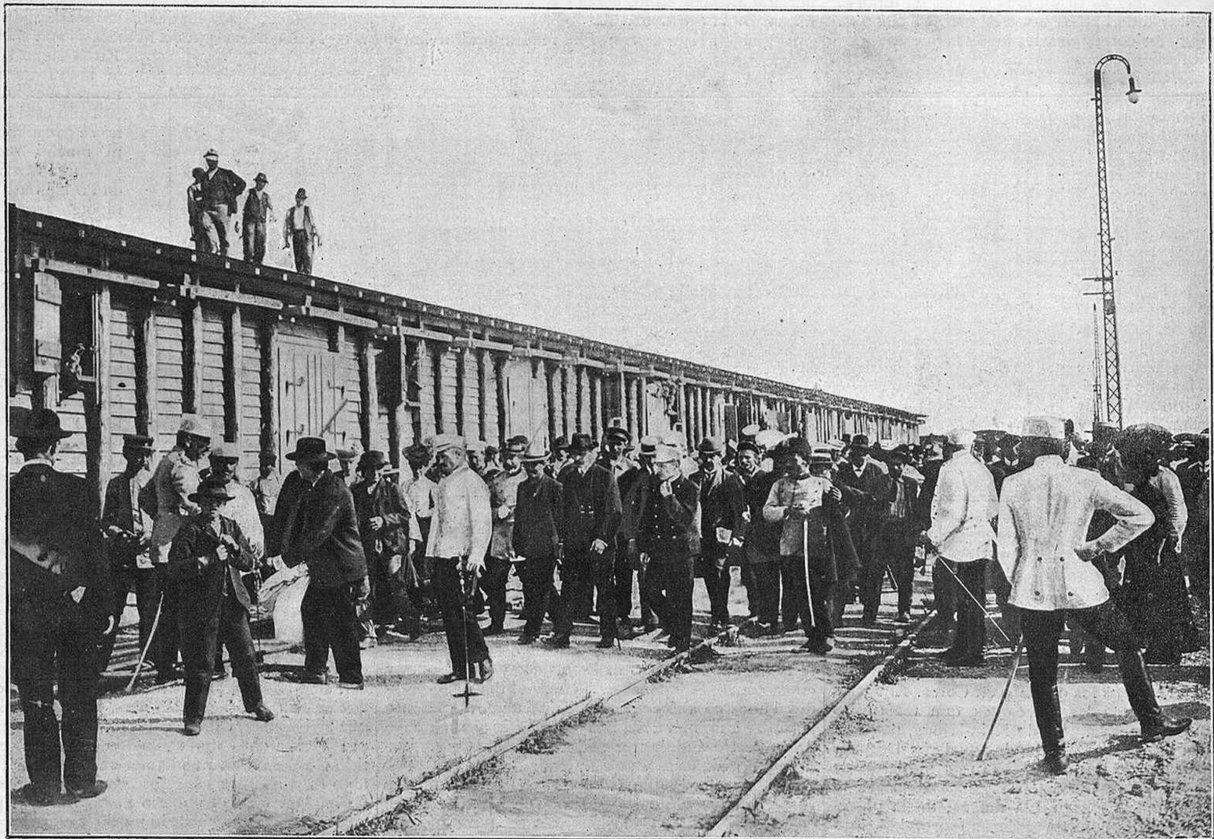
LOS AMOTINADOS DEL «PRÍNCIPE POTEMKINE» TOMANDO EL TREN EN CONSTANZA PARA DIRIGIRSE AL INTERIOR. (+) EL SEGUNDO DE Á BORDO, POGOWNETZ. (De fotografía de «Photo-Nouvelles.»)
