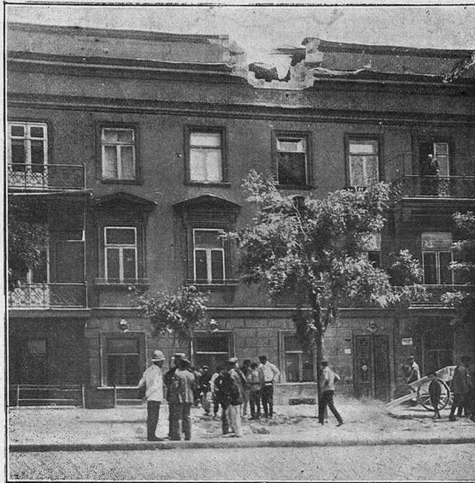
ODESSA. - Efectos del primer proyectil lanzado por el Príncipe Potemkine . Casa de la calle de Niejinskaia, cuya cornisa fué destruída por el proyectil.
