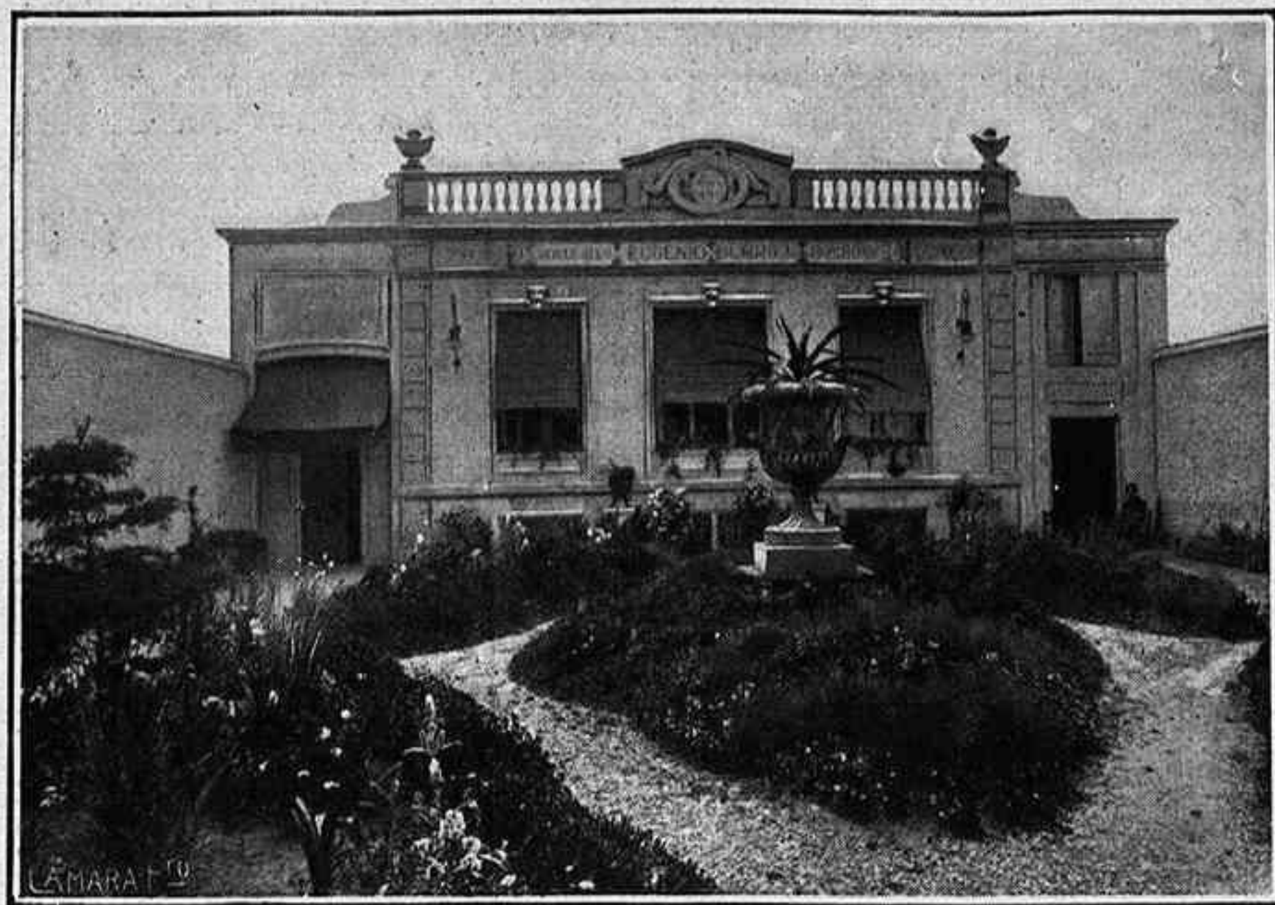
Vista exterior de la fábrica
