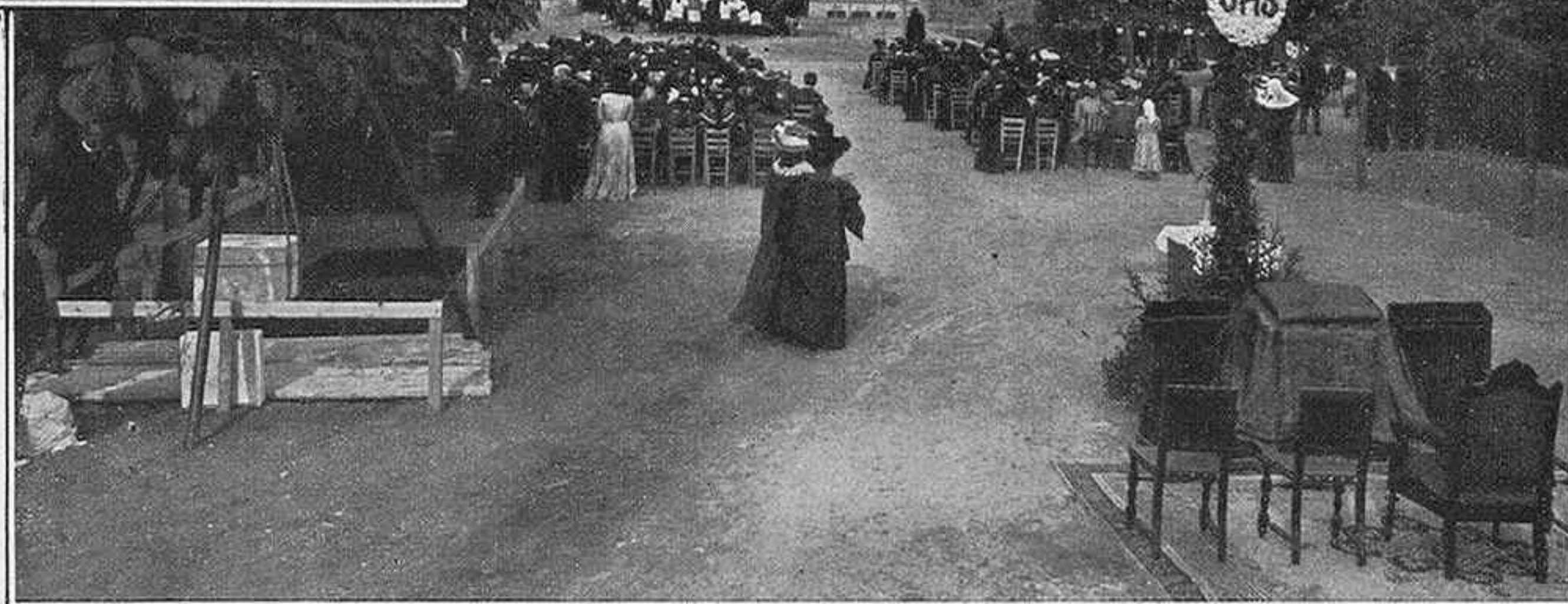
BARCELONA. - Fiestas celebradas en la Casa Provincial de Maternidad y Expósitos. - Vista general del lugar en donde se celebró la misa de campaña. A la izquierda, la primera piedra de la iglesia que se va á construir (de fotografías de Merletti).
