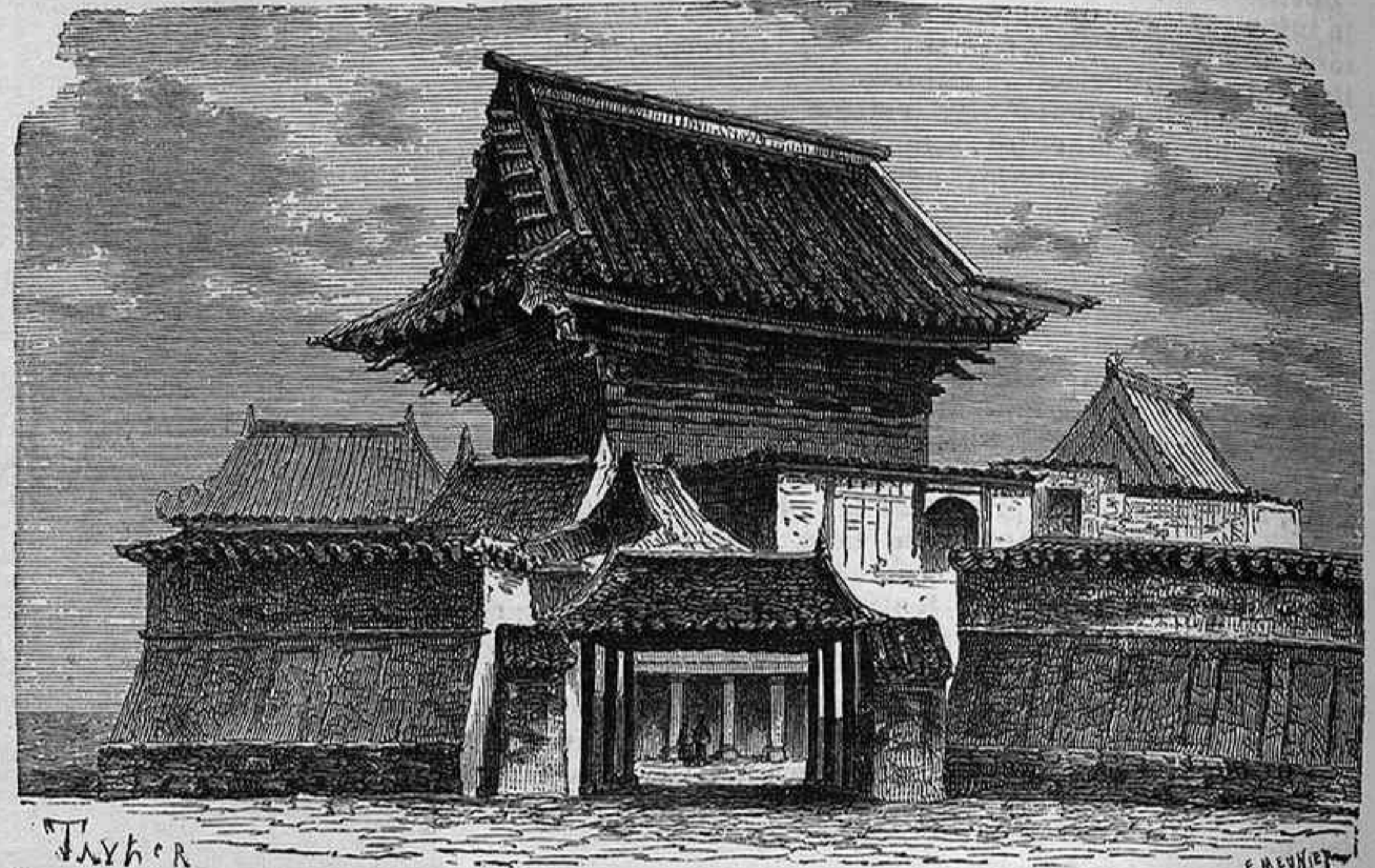
PUERTA DE LAS COCINAS
