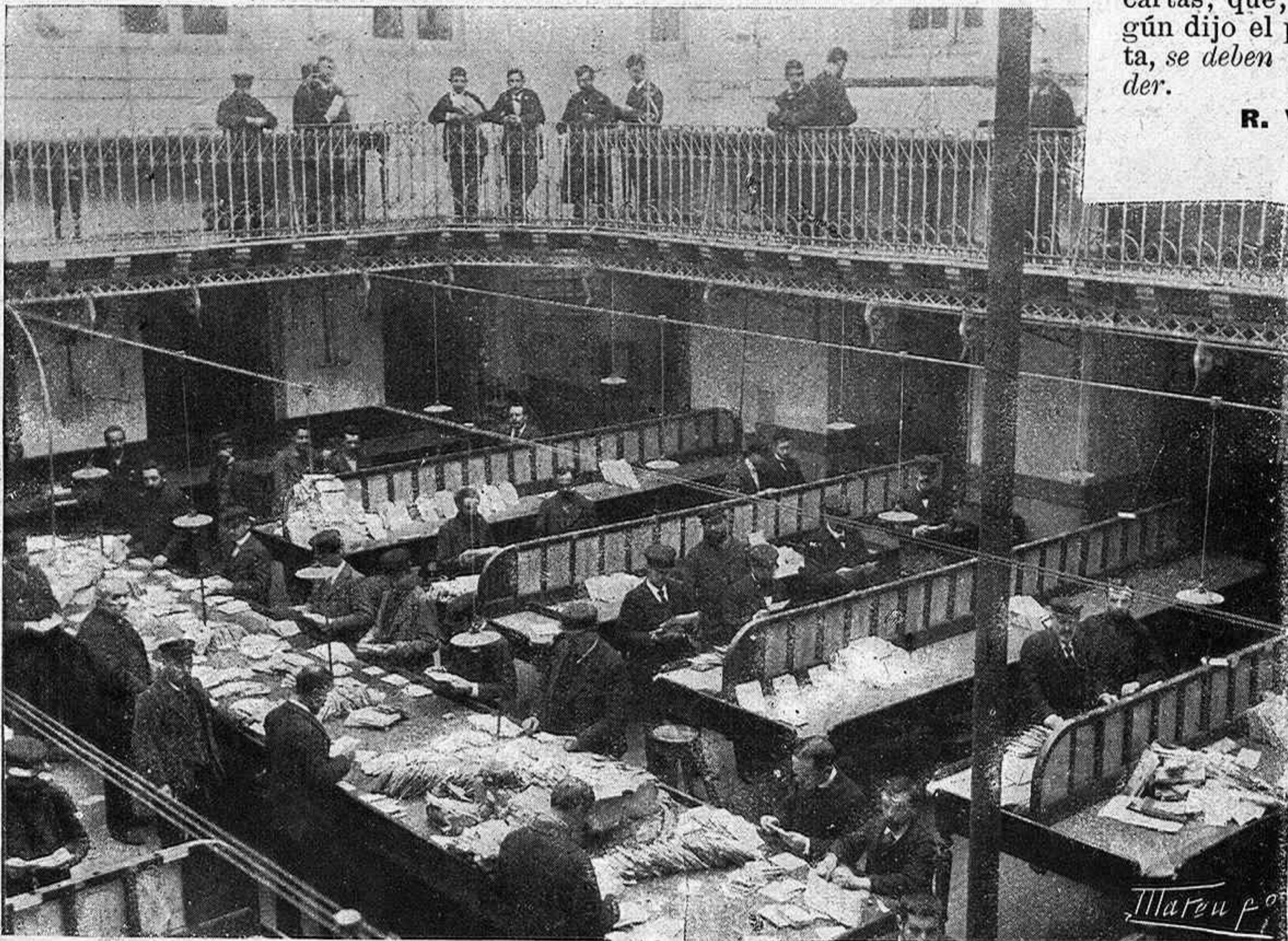
PATIO DE DISTRIBUCIÓN DE LA CENTRAL
