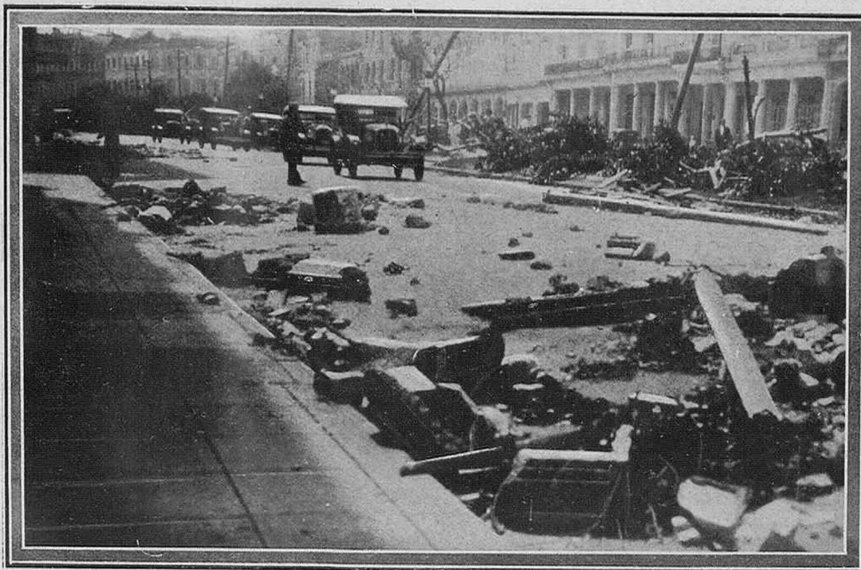
Aspecto que ofrecía el aristocrático Paseo del Prado, de La Habana, después del paso del terrible huracán
