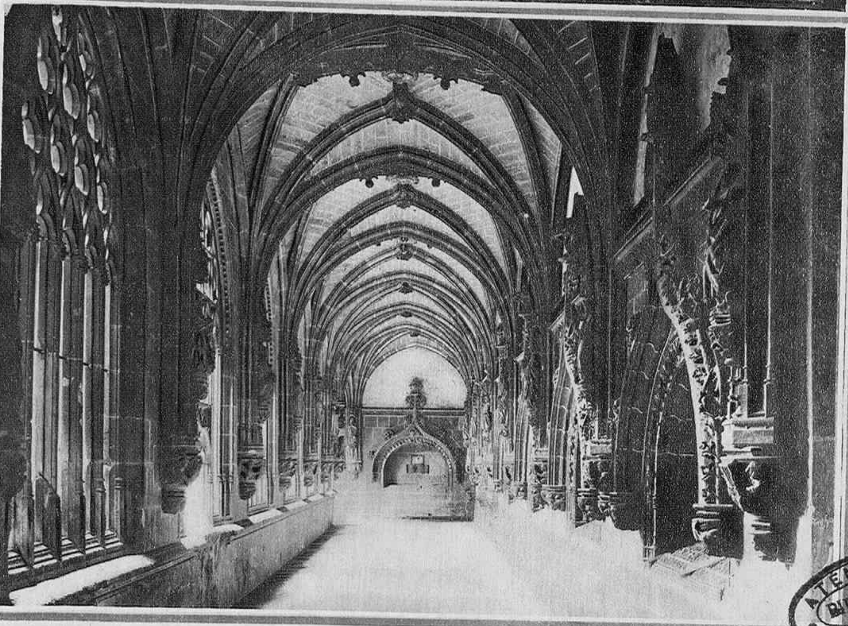
Exterior é interior del claustro gótico, labrado entre 1495 y 1566. Este claustro, llamado de los Caballeros, contiene, entre otros sepulcros notables, el de los condes de la Bureba
