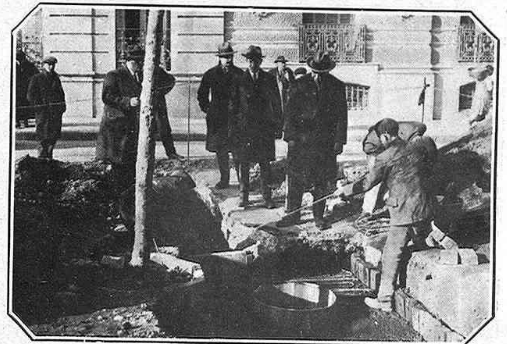
Cámara de registro en el barrio de Salamanca para el servicio automático
