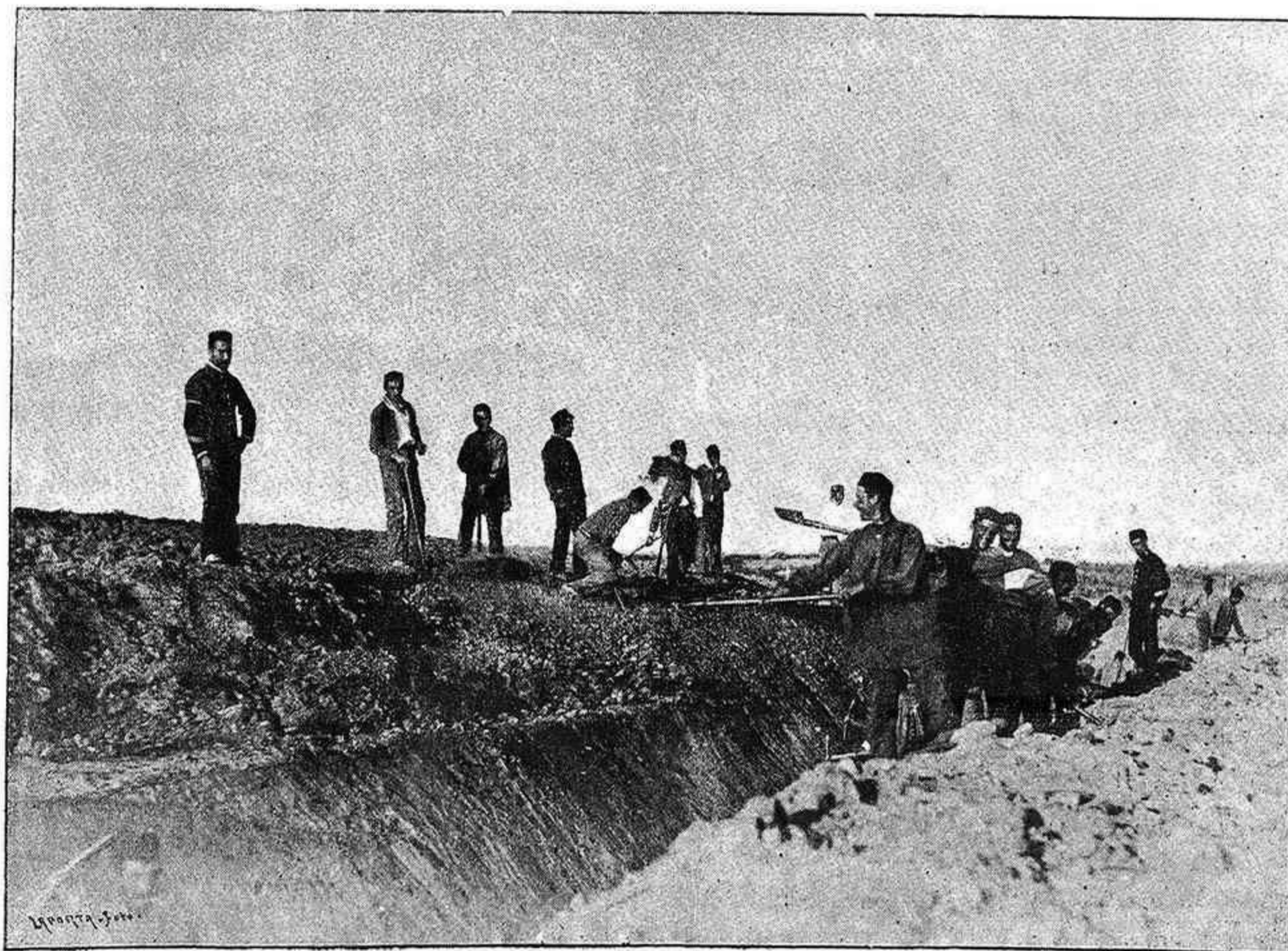
CAMPAMENTO DE LOS CARABANCHELES.—REDUCTO EN CONSTRUCCIÓN, (Fotografía directa del Sr. Compañy.)
