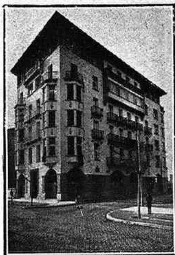
Casa del Paseo de Pamplona. Arquitecto: D. Regino Borobio.
