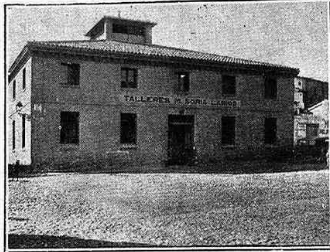
Vista exterior del edificio
