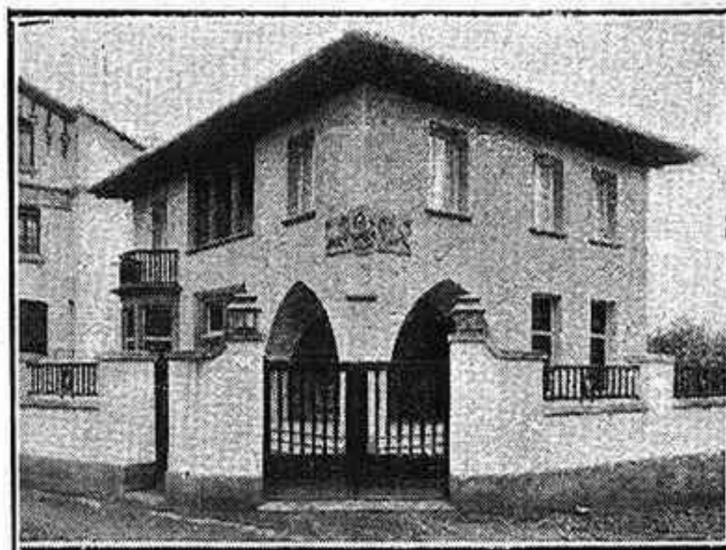
«Chalet» del Sr. Hernández, cuyo proyecto es del arquitecto Sr. Borobio
