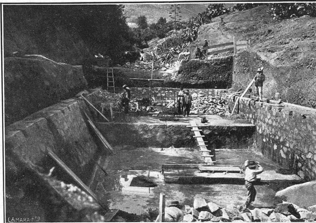
Detalle del embalse en construcción para suministro de aguas á la mina y abastecimiento del ferrocarril FOT. RIQUELME
