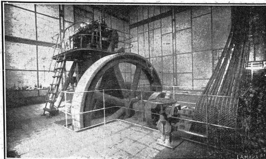
Motor Diesel de 200 cab. os, con acoplamiento para el movimiento del lavadero de mineral de plomo
