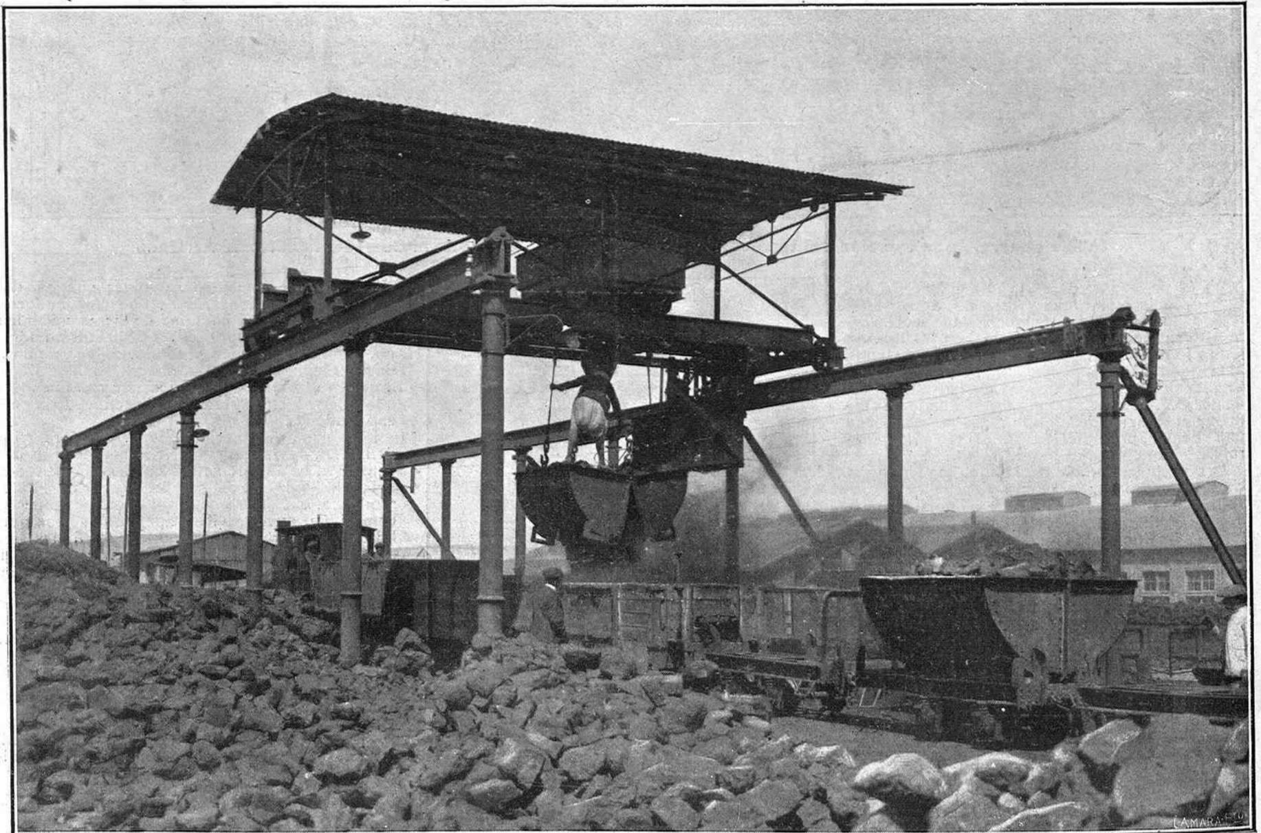
El transbordador para la carga de minerales, efectuando el cargamento de un tren con destino al muelle "Villanueva"
