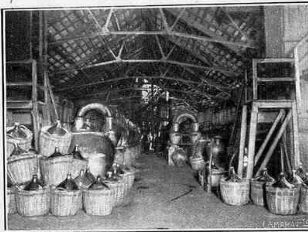
Sección de ácido clorhídrico
