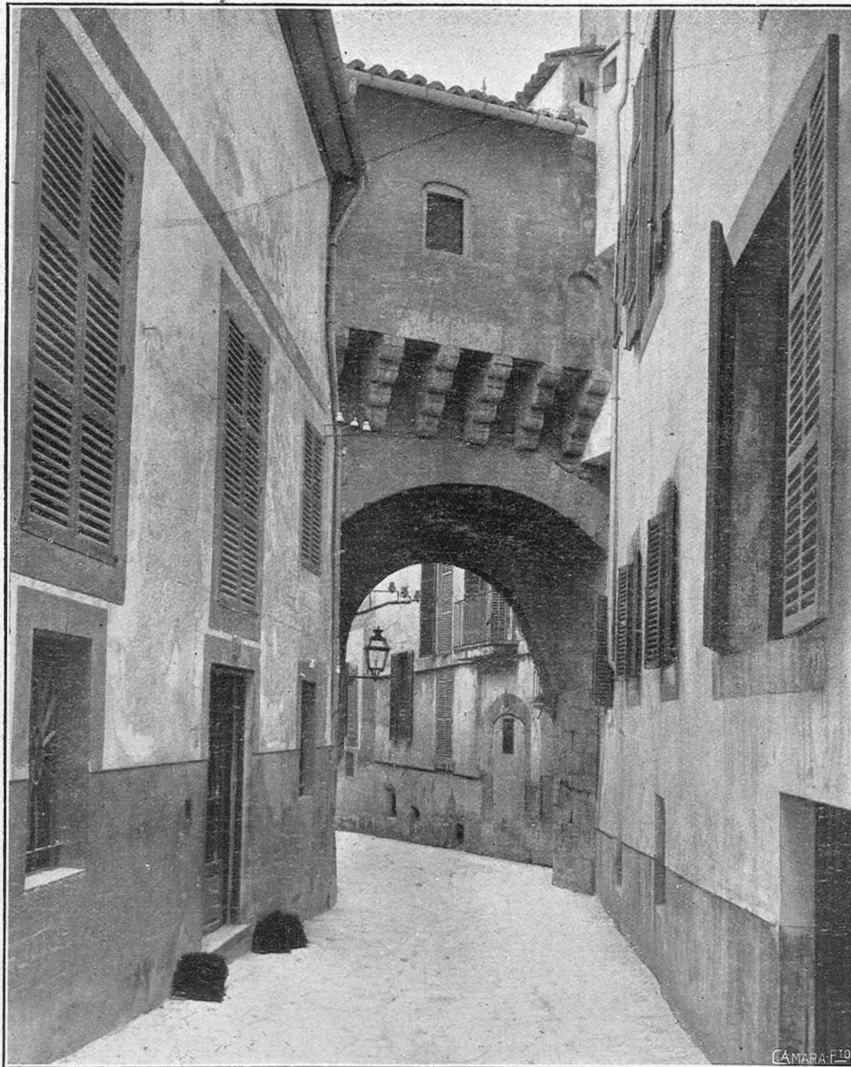
Arco de la Almudaina, denominado en la Edad Media con el nombre de «Puerta de las Cadenas», y que no obstante ser uno de los escasos restos de la dominación musulmana y constituir un interesantísimo recuerdo histórico y artístico, va á ser demolido por acuerdo del Ayuntamiento de Palma, con el único fin de ensanchar la calle en que se halla
