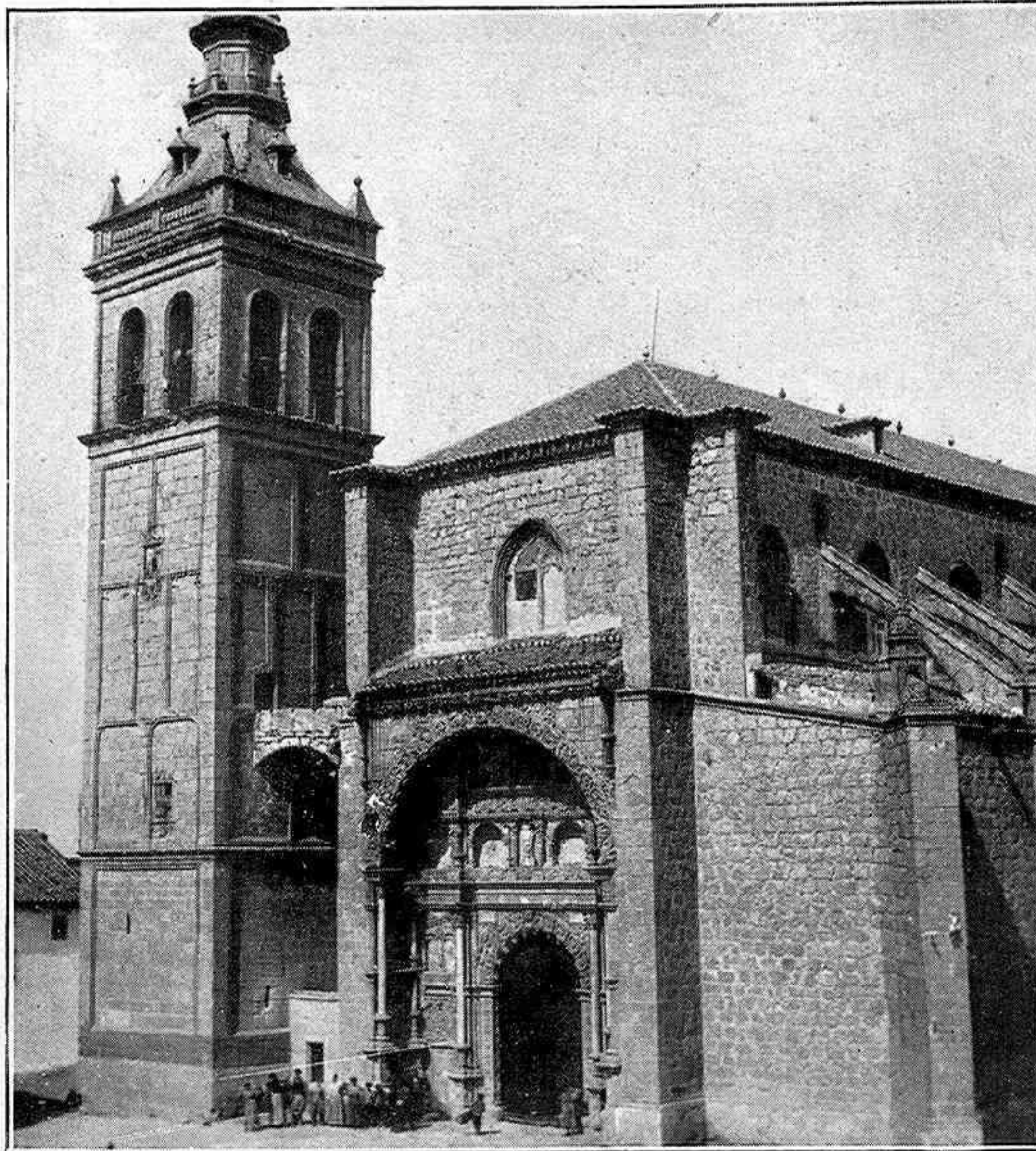
Vista exterior del templo y torre de la Colegiata del Corpus Cristi
