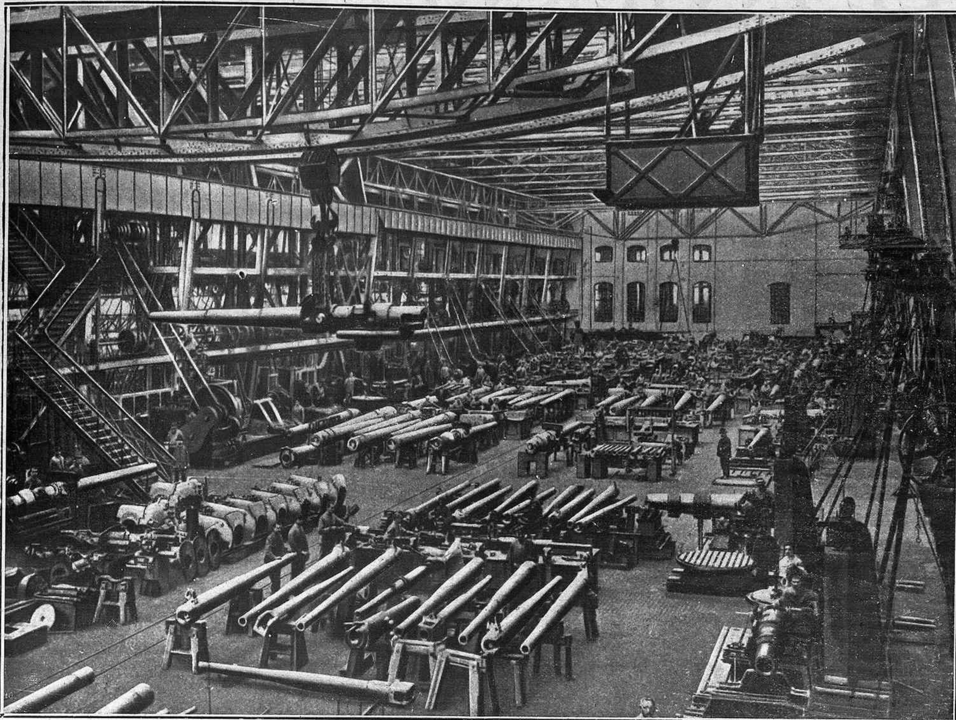
Gran nave para montaje de cañones
