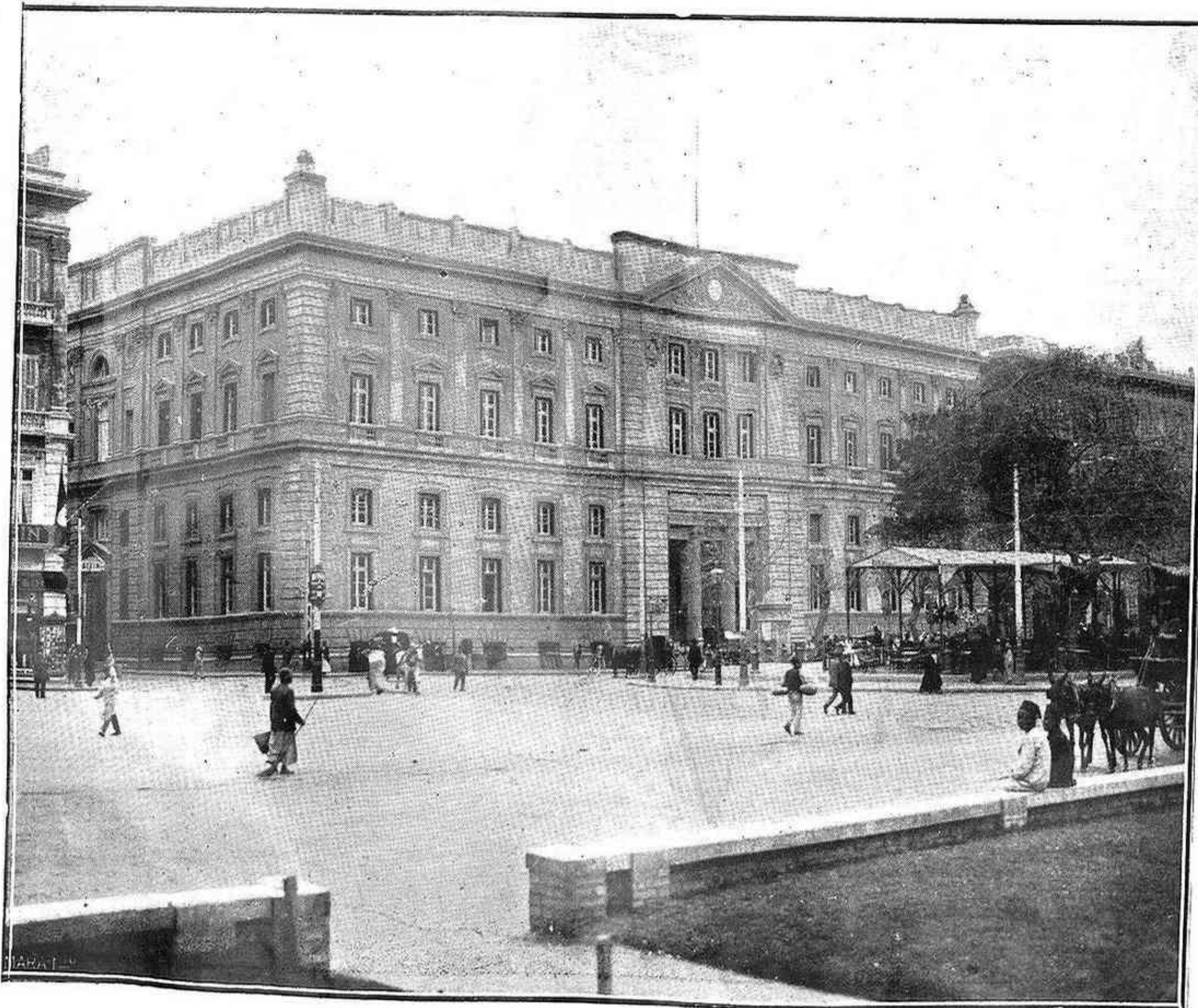
El edificio del Palacio de Justicia
