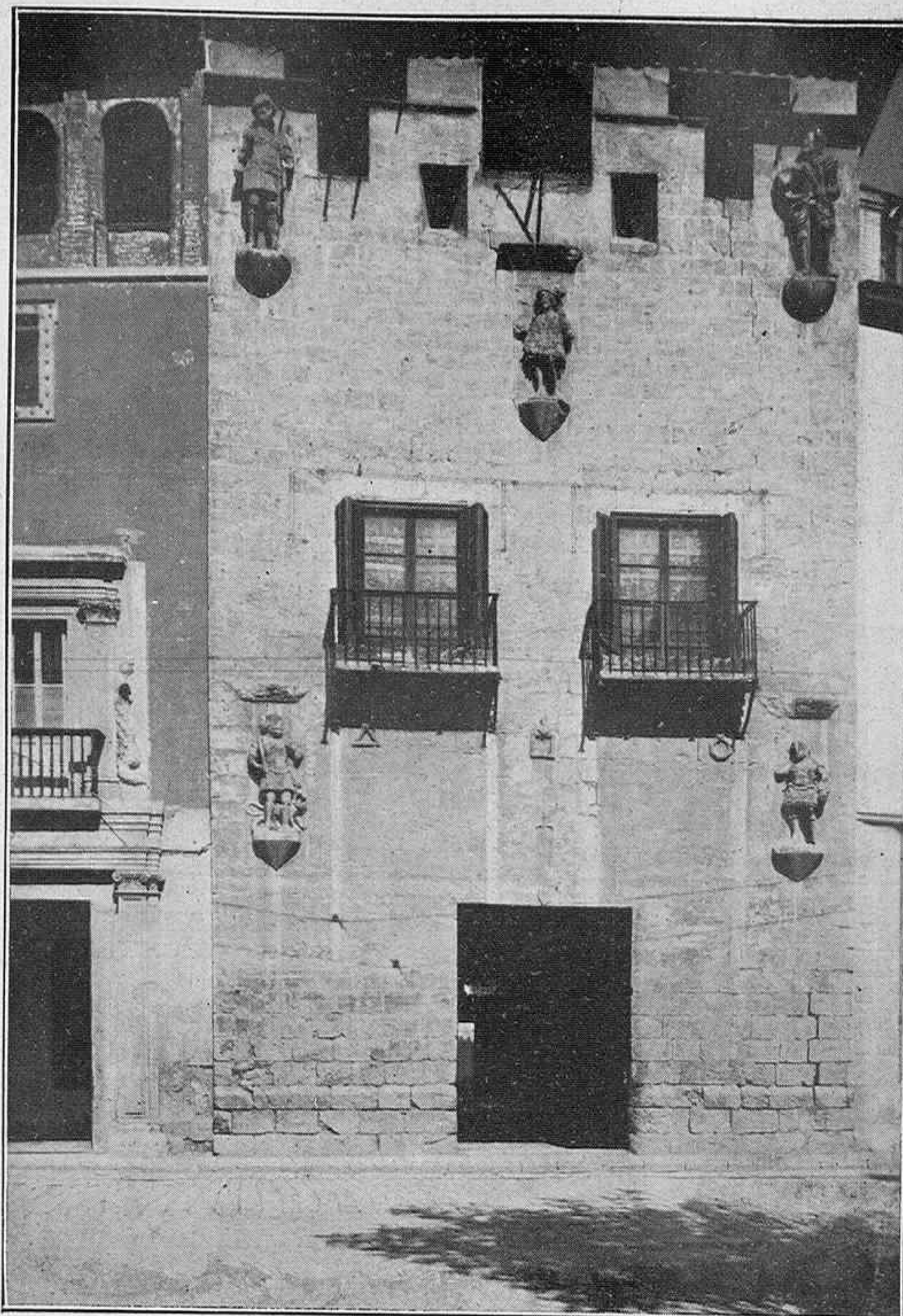
Fachada principal de «La Casa de los Tiros»
