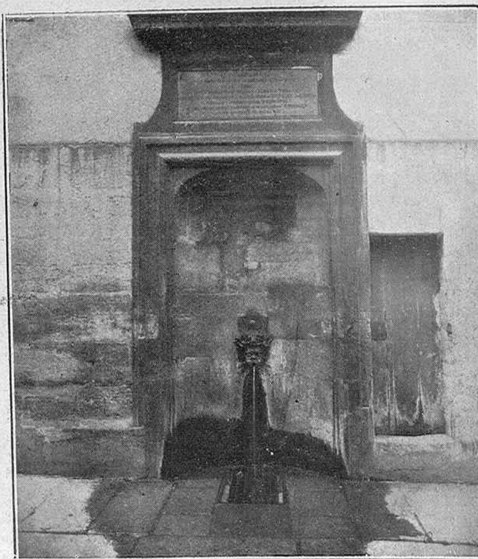
Fuentecilla de la calle Gavancière
