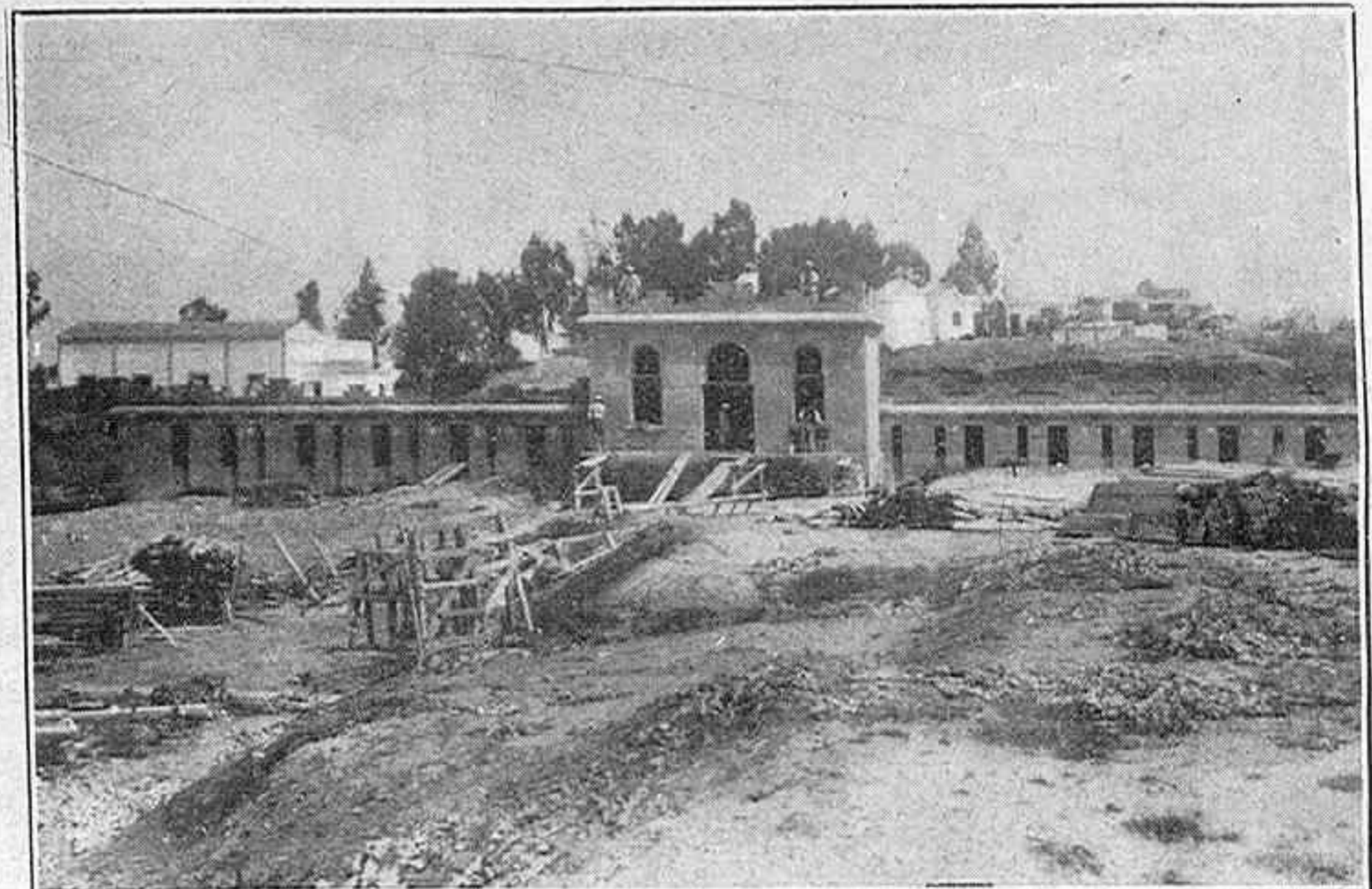
Abastecimiento de aguas de Alcázar. Depósito de reserva
