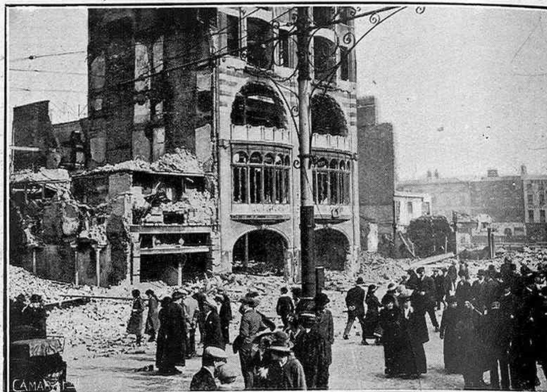
Destrozos ocasionados por la lucha entre "sinn-feiners" y tropas reales en la calle Sackville, de Dublin
