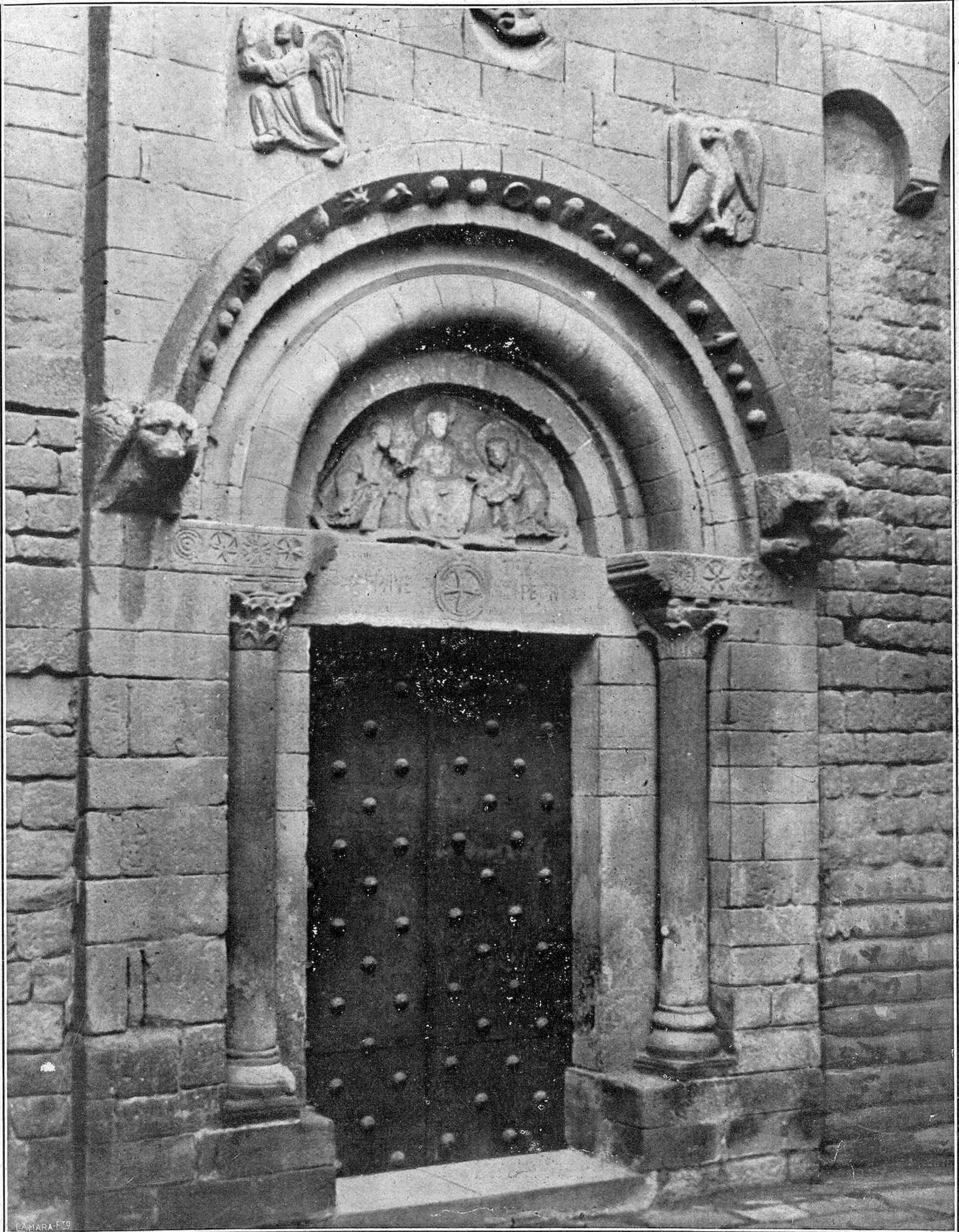
PUERTA PRINCIPAL DE LA IGLESIA PARROQUIAL DE SAN PABLO DEL CAMPO, DE BARCELONA, PERTENECIENTE AL MÁS PURO ESTILO ROMÁNICO, Y CUYA CONSTRUCCIÓN SE REMONTA AL SIGLO XII
