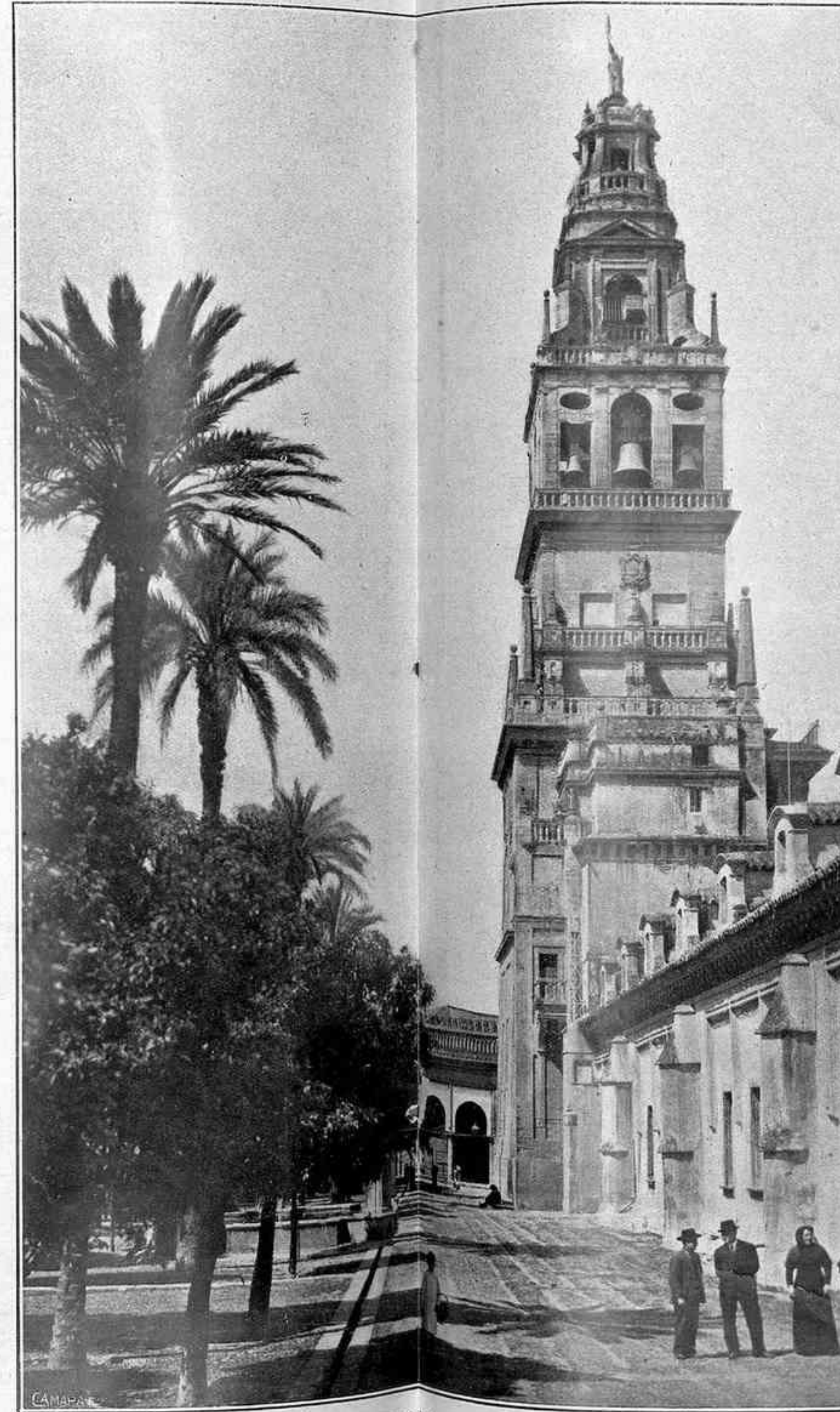
Córdoba.—Torre de la Catedral desde el patio de los Naranjos
