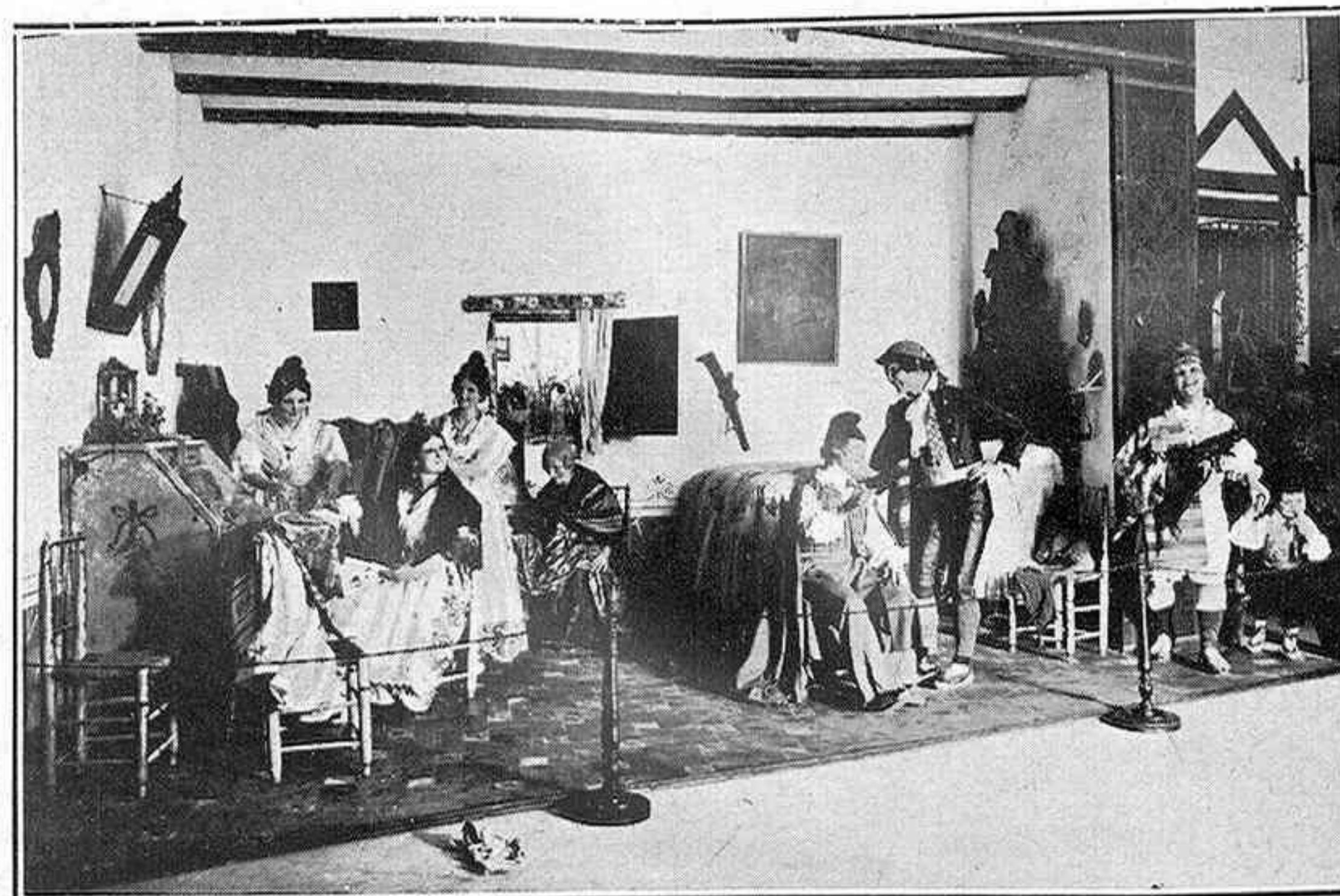
Instalación de Valencia
