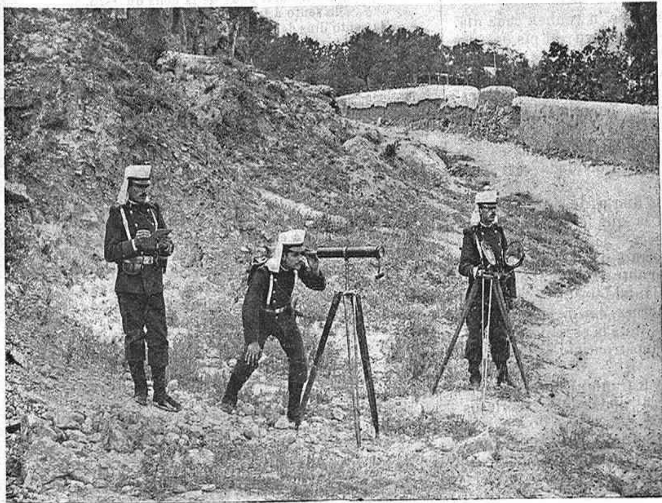
Aparato Mangin, pera transmetre despatxos de nit.
