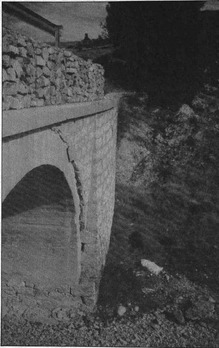
**El puente milagrosamente se tiene en pié, a pesar de tener agrietado todo el forjado**
