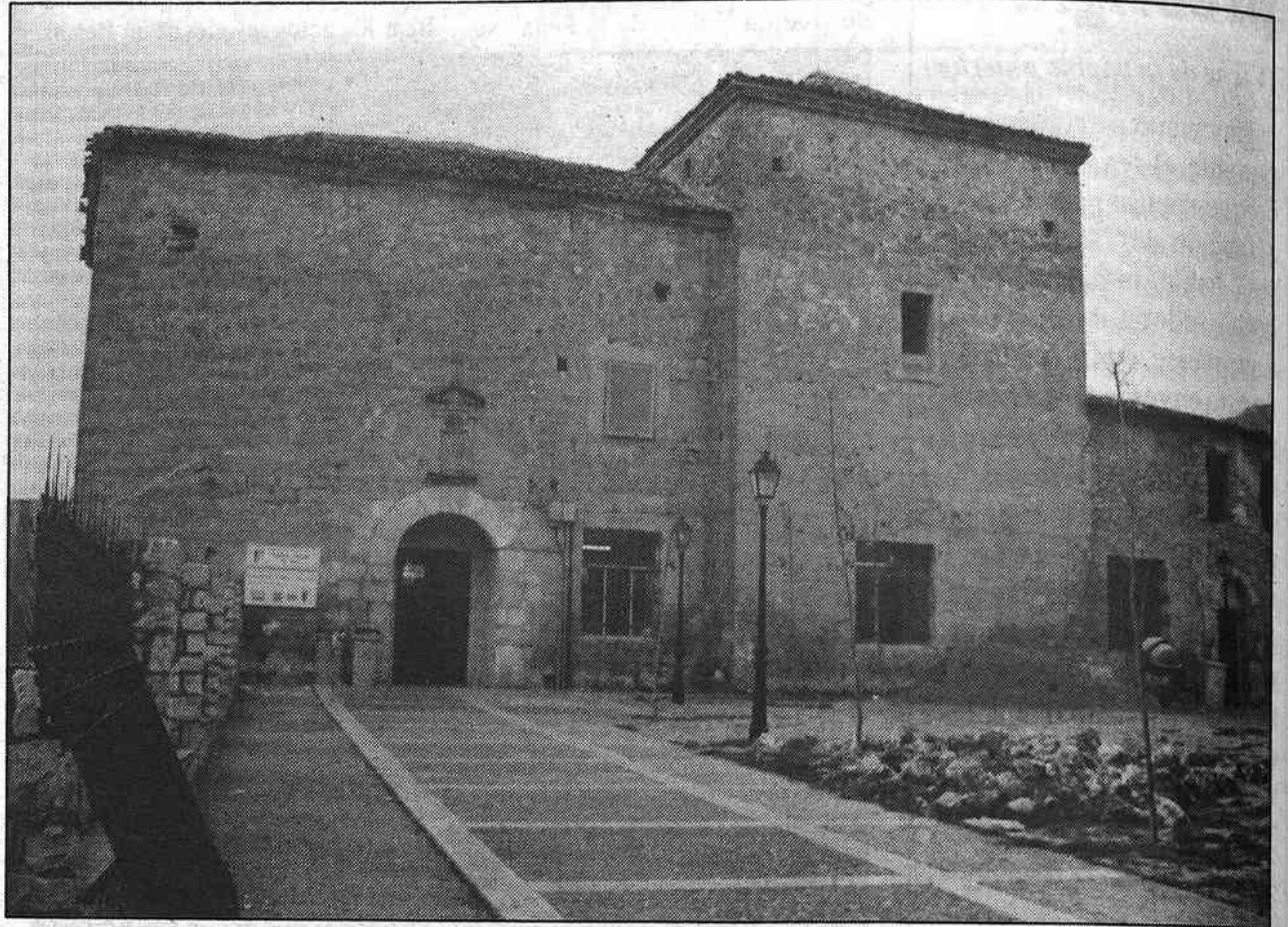
Vista de la fachada principal del Monasterio del Hospital de San José
