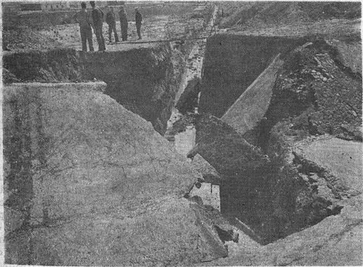
Tramo del Canal del Henares en que se produjo el derrumbamiento. Todo el agua se escapó a través de la zanja abierta por Dragados para meter las tuberías de la conducción de aguas de Mancomunidad —como se puede apreciar en la fotografía— y que pasa por debajo del Canal, precisamente en el lugar donde se sufrió el reventón. (Foto: Luis Barra)
