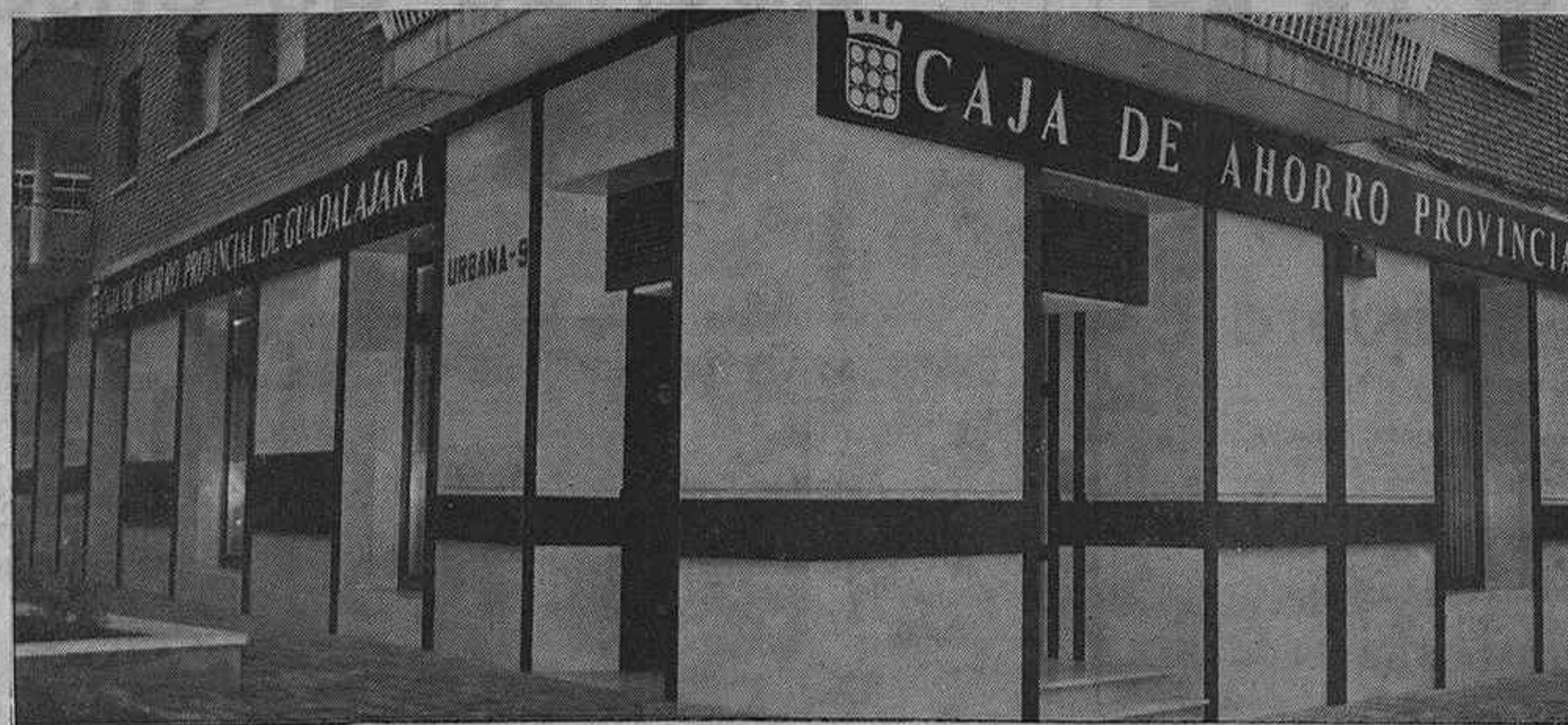
Fachada de la nueva Oficina, Urbana 9.
