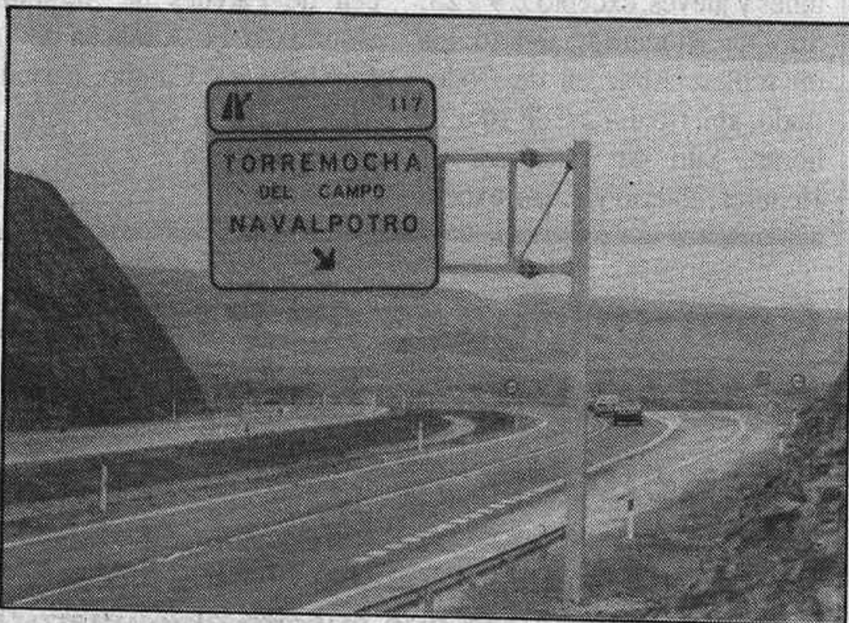
Durante este año se han terminado los tramos que faltaban de la autovía de Aragón
