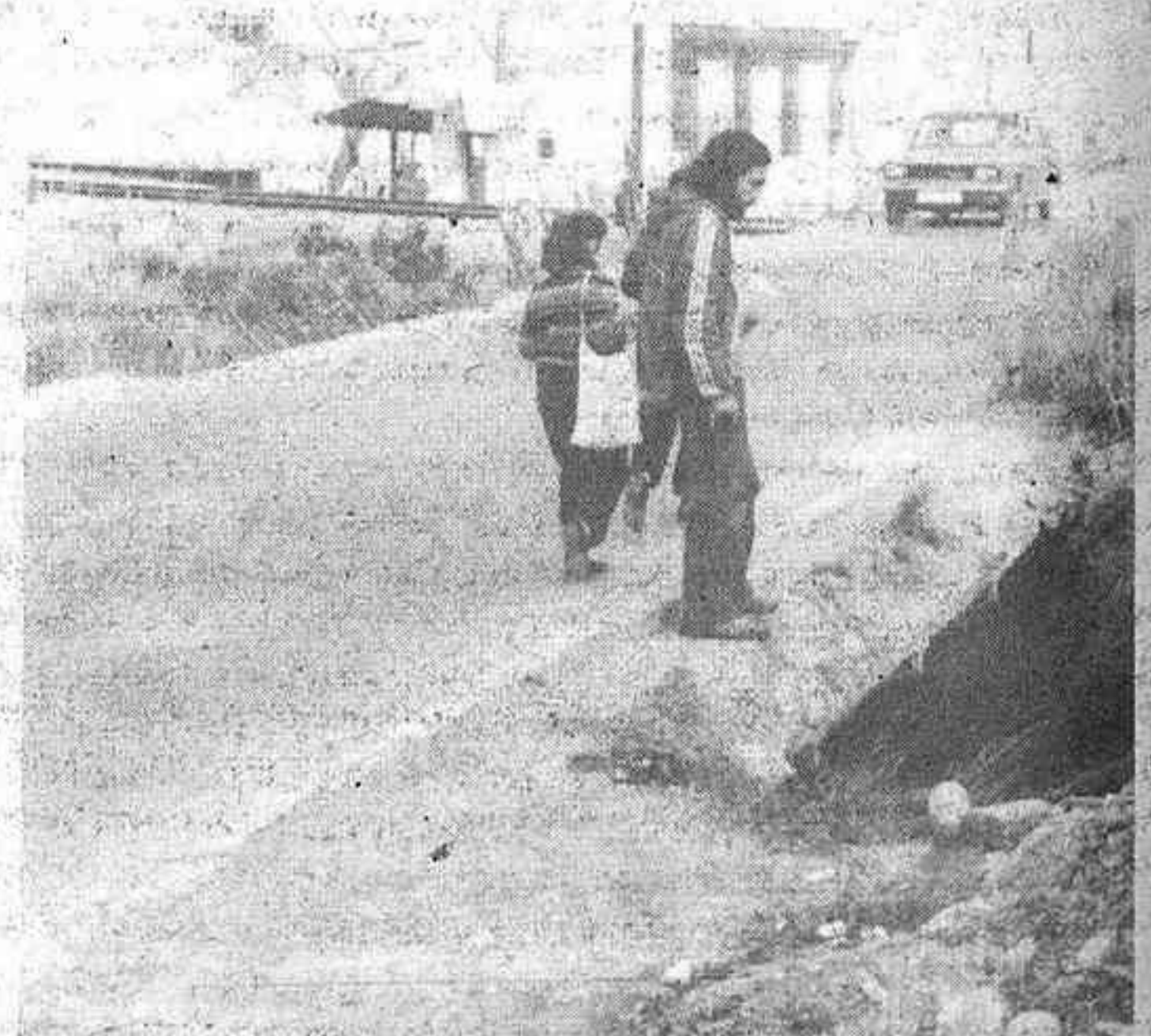
Los niños tienen miedo de continuar por la acera y pasan por la carretera con el consiguiente peligro
