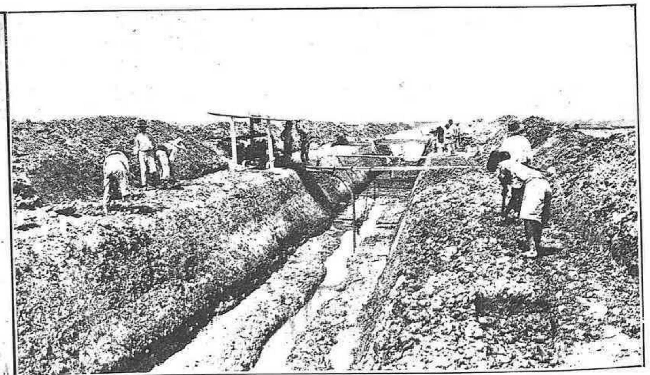
Construcción del canal general de conducción: saladares.
