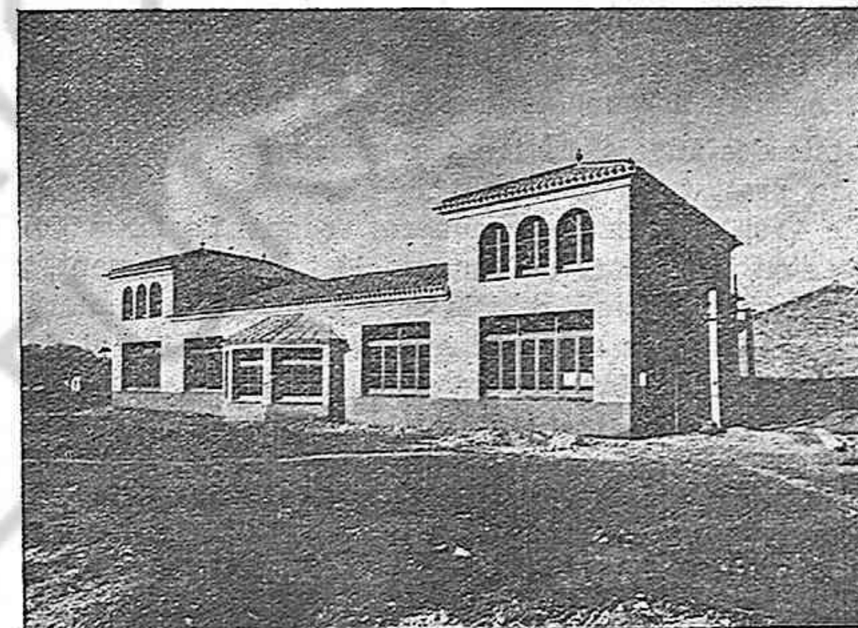
Exterior de la Guarderia a Terrassa (En construcció)
