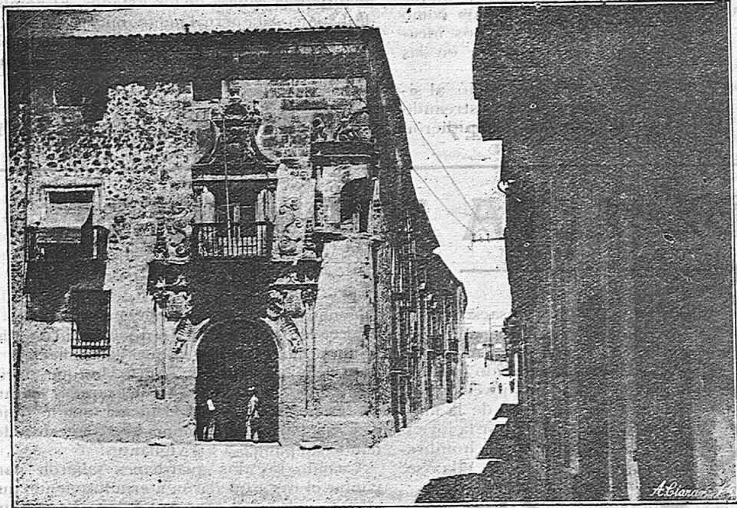
CASA CUARTEL de la Guardia civil y calle de la Aduana Vieja.
