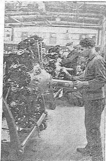
Nuevo motor de explosión BMW 32, de 9 cilindros y cuatro tiempos, que se ha introducido con gran éxito en los aviones alemanes
