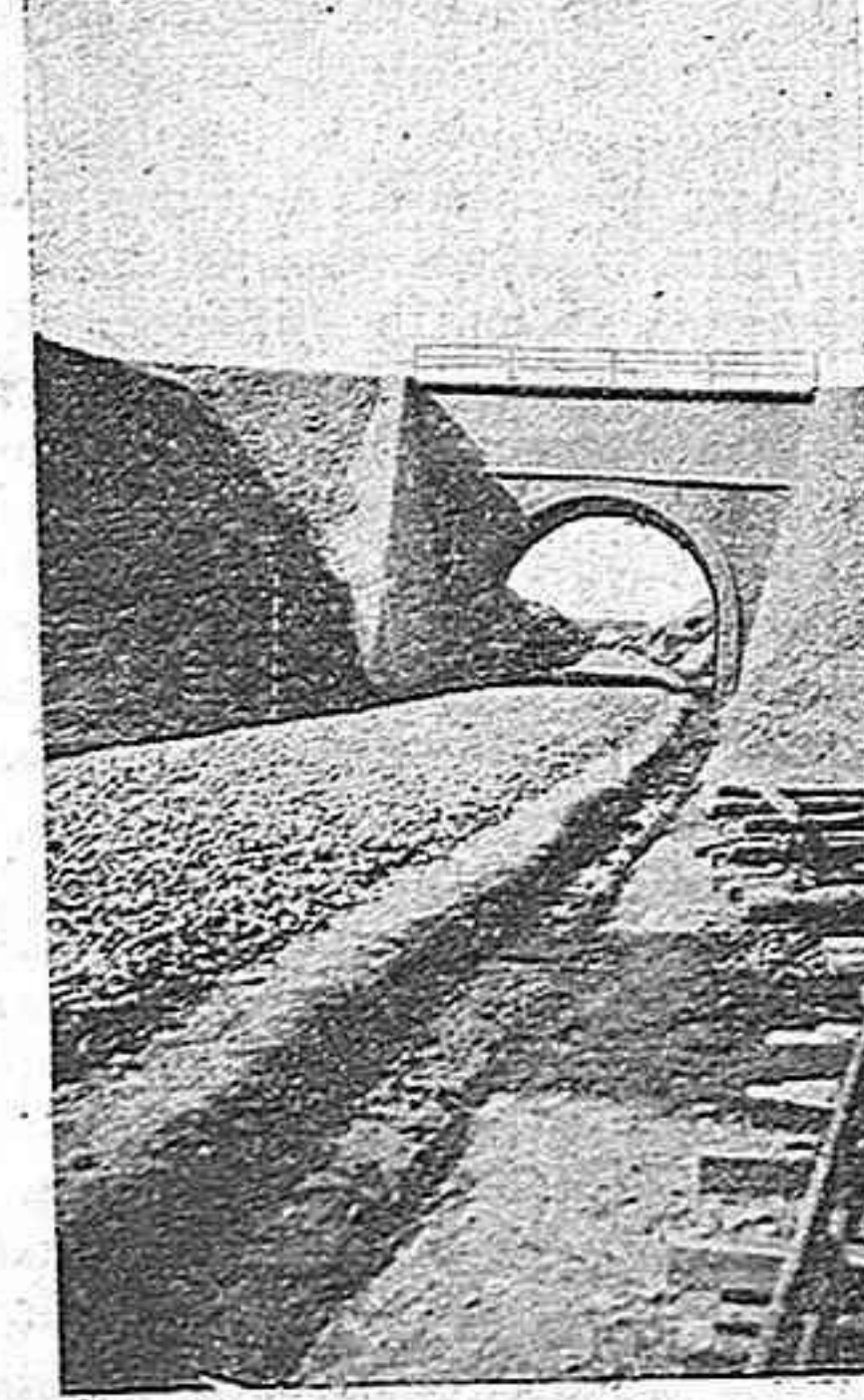
Hay camino abierto, esperando el tendido de los railes...
