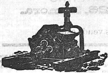
Nuevo aparato perfeccionado para extraer agua, aprovechando los arcaicos hasta la última gota del líquido, y con el más pequeño esfuerzo de las caballerías, por la disposición de la artesa y por la suavidad de los rozamientos montados sobre armadura de cilindros.
