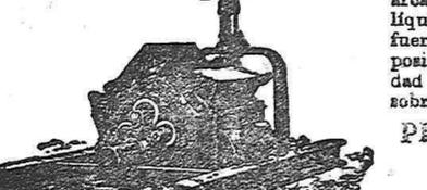
Nuevo aparato perfeccionado para extraer agua, aprovechando los arcañones hasta la última gota del líquido, y con el más pequeño esfuerzo de las caballerías, por la disposición de la artesa y por la suavidad de los rozamientos montados sobre armadura de cilindros.
