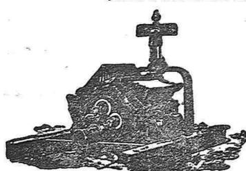
Nuevo aparato perfeccionado para extraer agua, aprovechando los arcañones hasta la última gota del líquido, y con el más pequeño esfuerzo de las caballerías, por la disposición de la artes y por la suavidad de los rozamientos montados sobre armadura de cilindros.
