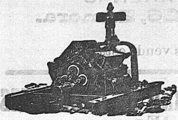
Nuevo aparato perfeccionado para extraer agua, aprovechando los arduos hasta la última gota del líquido, y con el más pequeño esfuerzo de las caballerías, por la disposición de la arca y por la suavidad de los rozamientos montados sobre armadura de cilindros.
