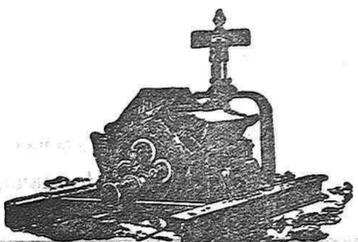
Nuevo aparato perfeccionado para extraer agua, aprovechando los arcauces hasta la última gota del liquido, y con el más pequeño esfuerzo de las caballerías, por la disposición de la artesa y por la suavidad de los rozamientos montados sobre armadura de cilindros.
