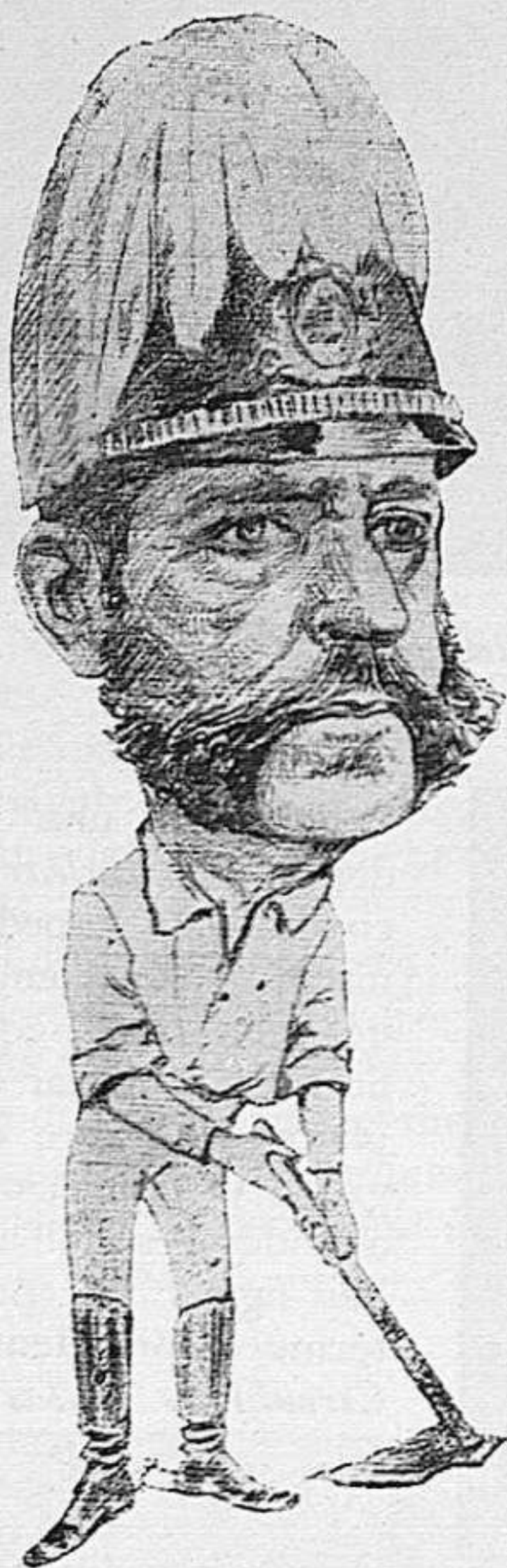
Derribo de Murallas
